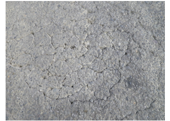
路面に亀甲状ひび割れがある
