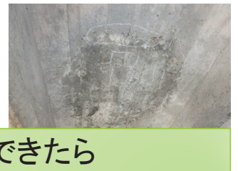
路面に亀甲状ひび割れがある
