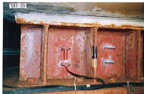
中間支柱上の支承の変位測定
