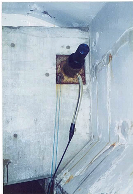
外ケーブルのロードセルによる軸力測定
