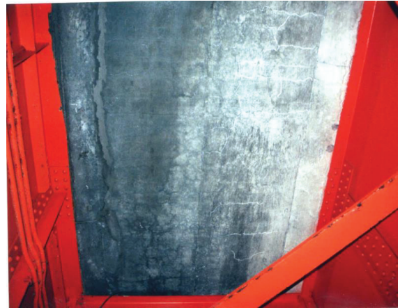
B橋のRC床版下面状況
