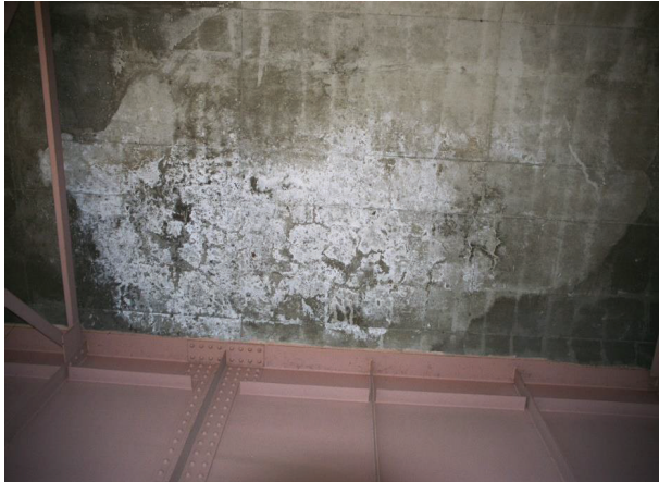
A橋のRC床版下面状況
