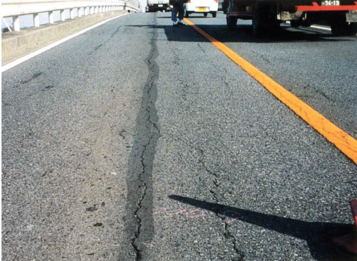
● 鋼箱桁橋の舗装に生じたひび割れ
