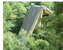
地震による落橋
