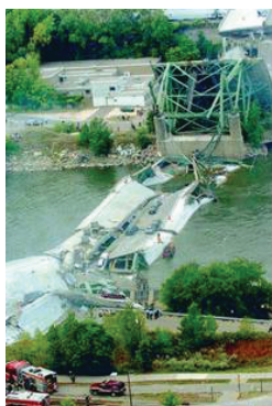
米国I-35W橋の崩落事故
