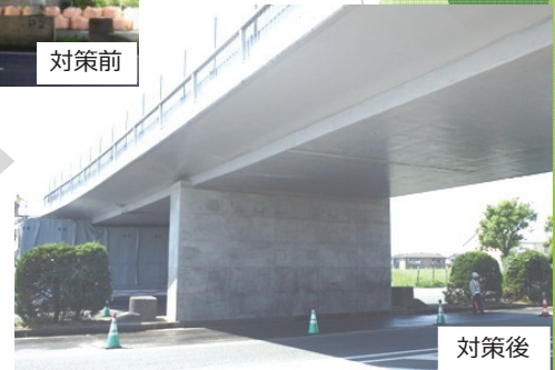
耐震補強の施工例（国交省HP）
