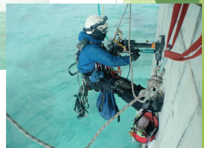
道路管理者と連携し、コア抜き調査を継続的に実施
