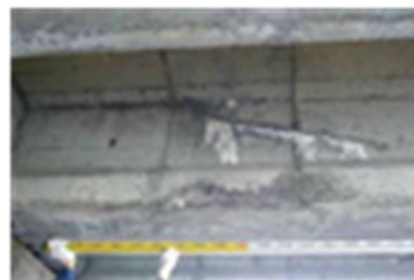
図-3 シースに沿ったひび割れの例
