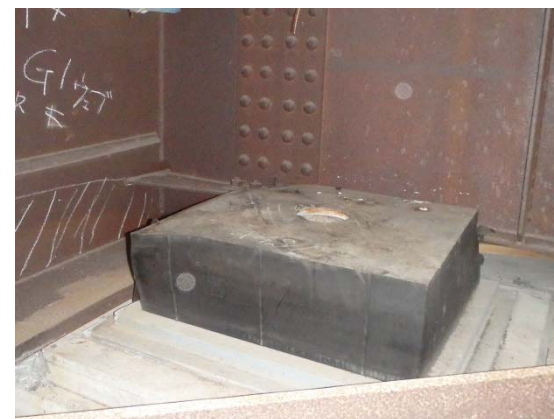
支承取付け ボルトの損傷
