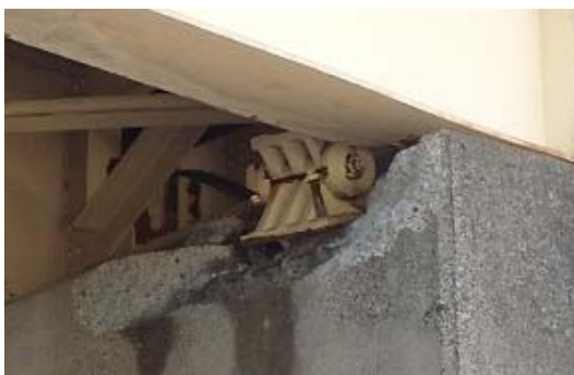
橋座コンクリートの損傷
