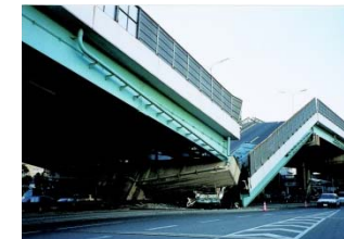
兵庫県南部地震による 橋梁の被害
