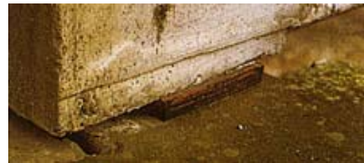
鬼怒川橋梁(ゴム支承)
