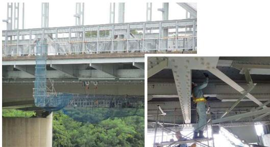
橋梁補修工事で設置した足場を橋梁点検にも利用することで、足場と規制帯の費用を縮減。現道交通規制日数も短縮。
