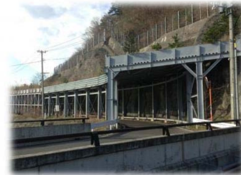
大倉シェッド 【昭和 38 年建設】
