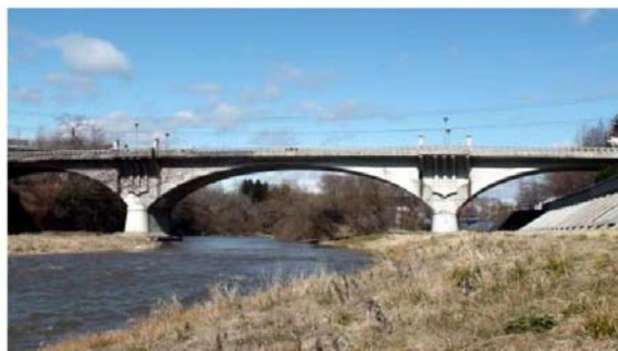
大橋 【昭和 13 年架設】
