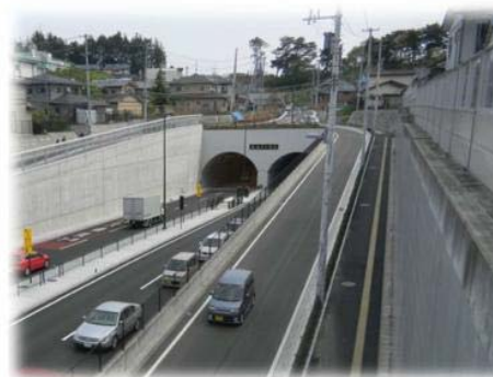
北山トンネル 【平成 23 年建設】
