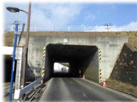
【泉ヶ丘横断道 (車道) (泉区泉ヶ丘 1 丁目)】
