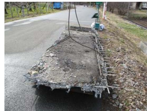
床版撤去時の状況（損傷程度を調査・評価）
