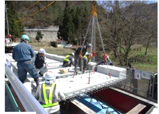
②床版の設置
