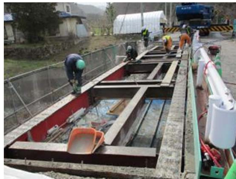
床版撤去時の状況（損傷程度を調査・評価）
