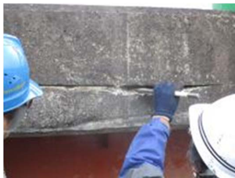
② 浮き箇所のはつり
