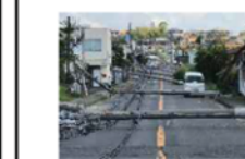
＜電柱倒壊による道路閉塞＞
