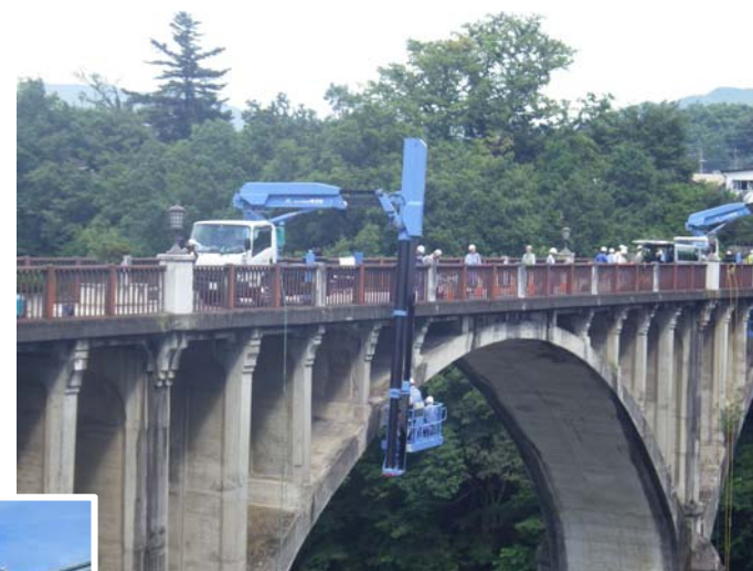
秩父橋（埼玉県） 令和元年度
