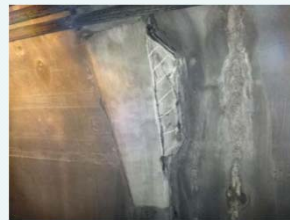
▲トンネル目地部
