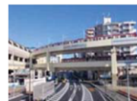
＜連続立体交差事業＞
