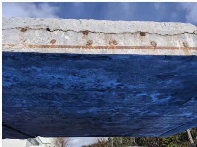
主鉄筋に沿った水平ひび割れと、配力筋に沿った水平ひび割れを確認
