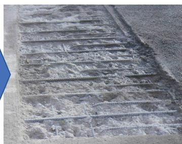
床版上面の土砂化
