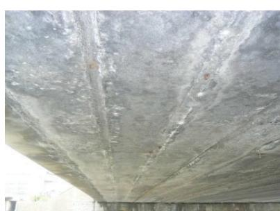
鋼材位置の塩化物イオン量 約3kg/m<sup>3</sup>
