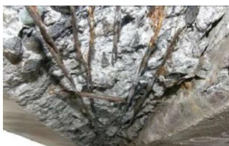
損傷が軽微な段階 (予防保全段階) → 塩分浸透を防ぐための塗装や含浸材の塗布
