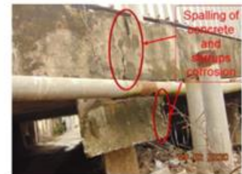
いずれも漏水のある梁端部で劣化が顕著
