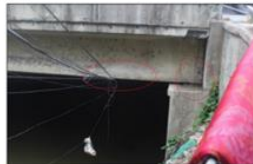
いずれも漏水のある梁端部で劣化が顕著
