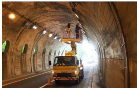
近接目視により、附属物等の鋼材腐食の状況を確認
