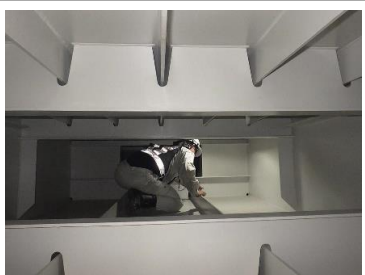
箱内空間が狭い箇所等における近接目視
