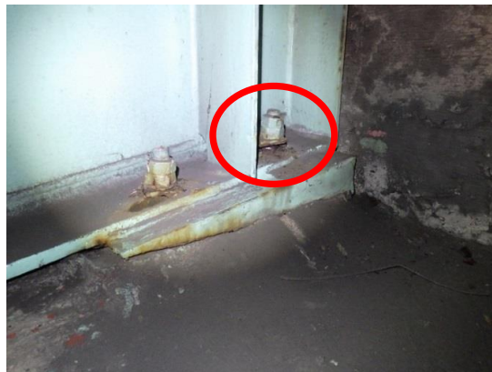
近接目視の状況(変状の確認は困難)
