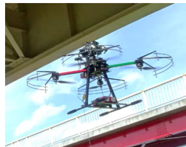
▲橋梁の損傷写真を撮影する技術 (ドローンの活用)
