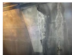
▲トンネル目地部
