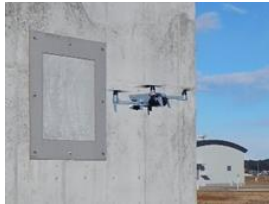
ドローンによる損傷把握
