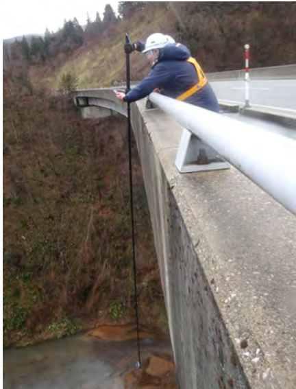
(II-1) 自撮り棒を橋面から降ろし、撮影
