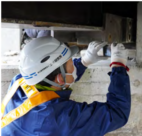
(I)近接目視点検
