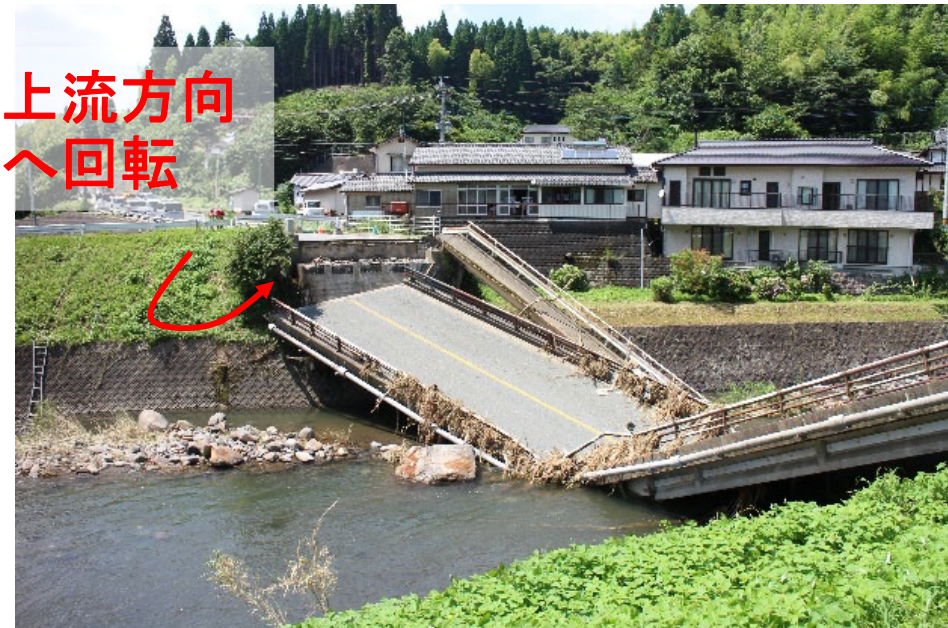
1) 左岸下流側より
