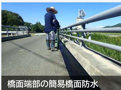
伸縮装置の漏水補修
