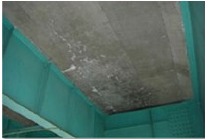
損傷の兆候無し（5年前）
