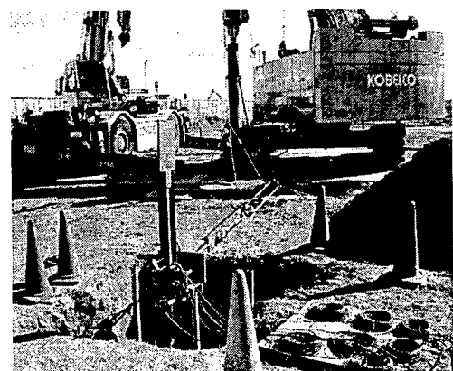
図-4.8 杭の水平載荷実験状況
