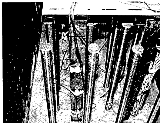
図-4.14 小径ドレーン設置状況
