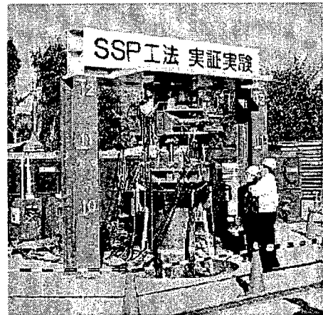
写真-4.2 実証実験状況
