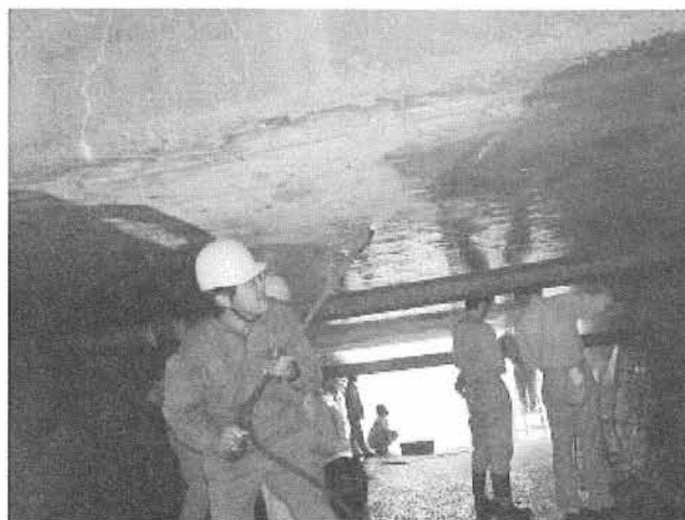
(b) 脇谷川橋 散水
