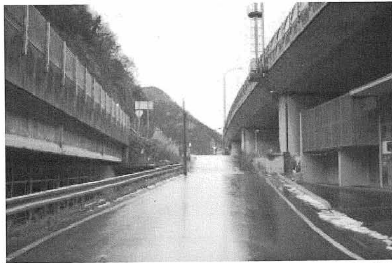
図-2.8 測定対象径間と隣接する施設
