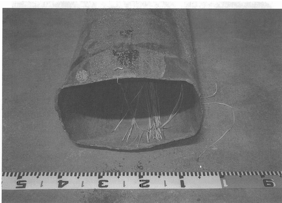
写真-参-16 杭体損傷状況②（ケース2：薄肉鋼管杭）
