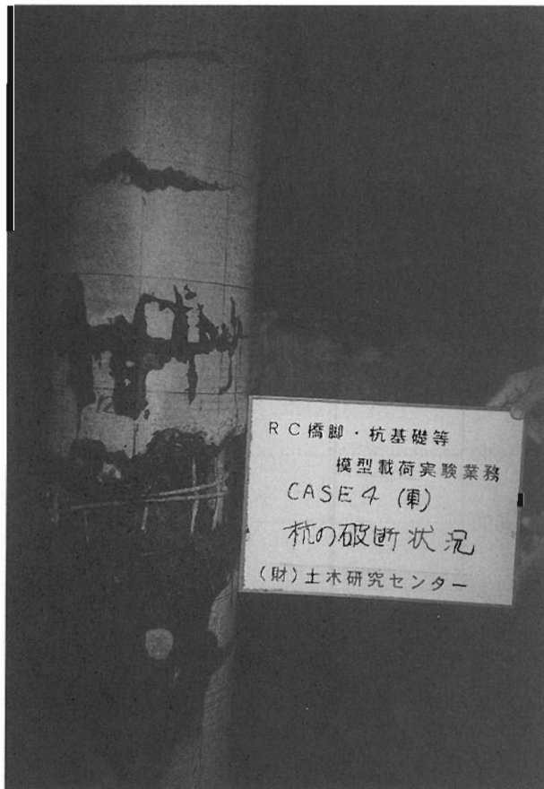
写真-4-2 PHC 杭の損傷状況
