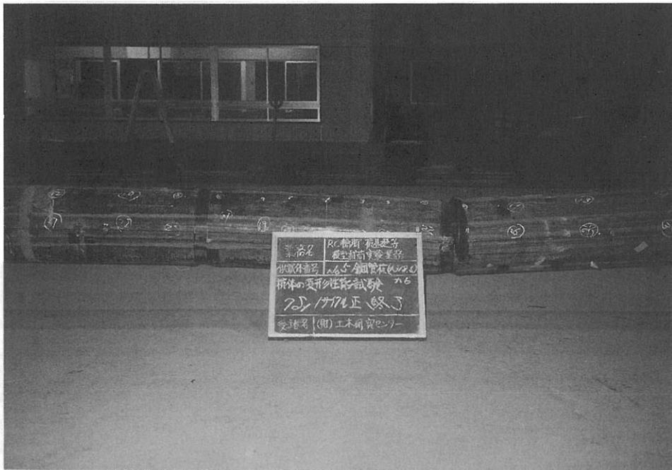
写真-3-2 試験終了時状況 (鋼管杭)
