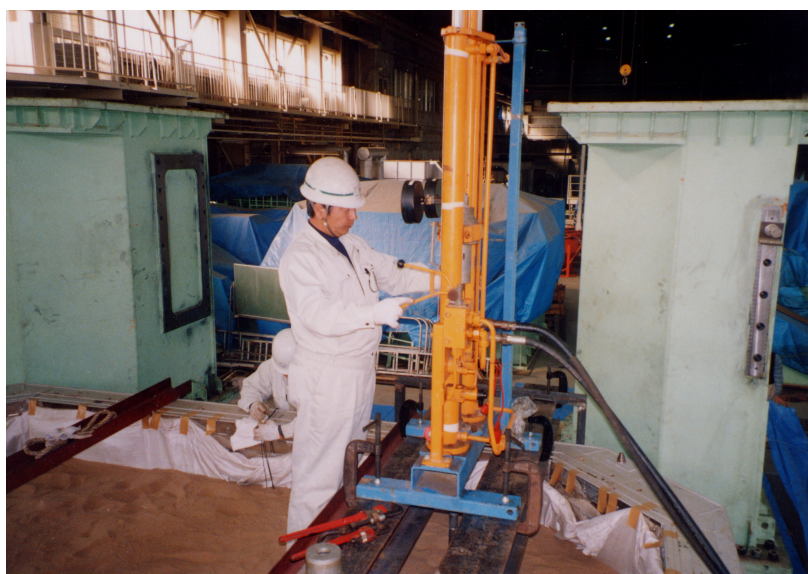
写真-2.6 サウンディング試験状況
