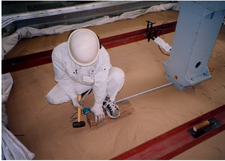
写真-2.7 S波速度測定状況
