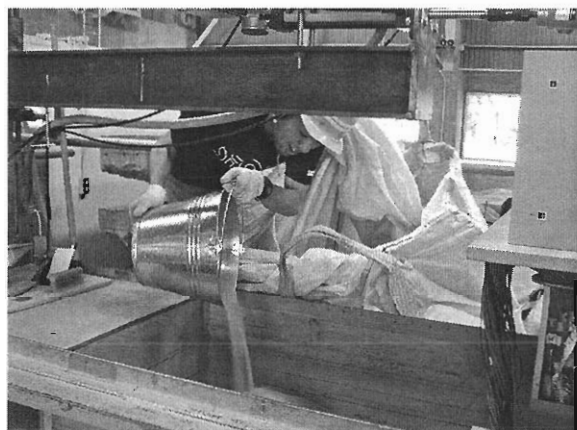
写真-2.9 根入れ部への砂の投入
