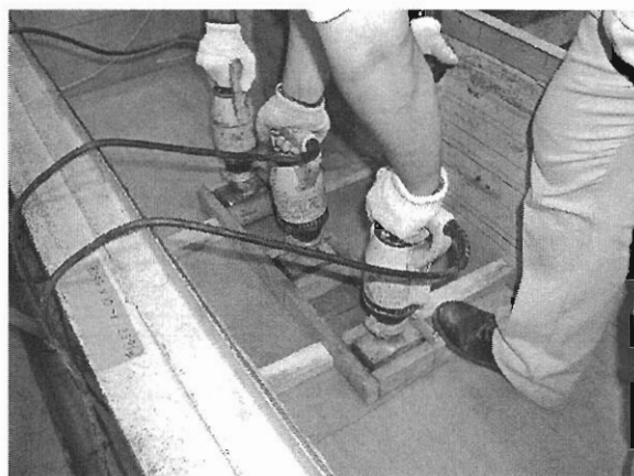
写真-2.8 支持地盤の締固め状況
