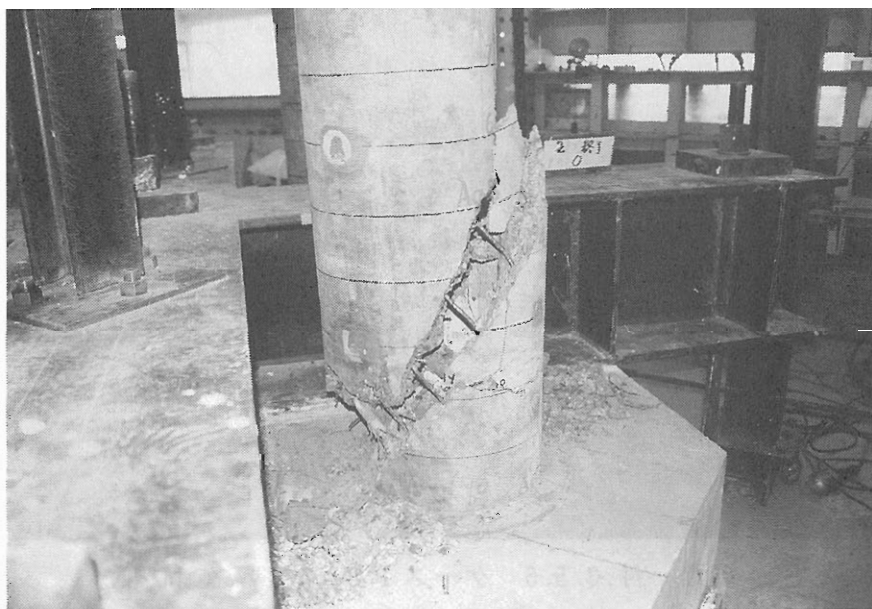
写真-付. 3. 5. 7 ケース 1 1 実験終了 A 杭下部
