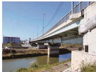
写真-1 豊田橋全景
