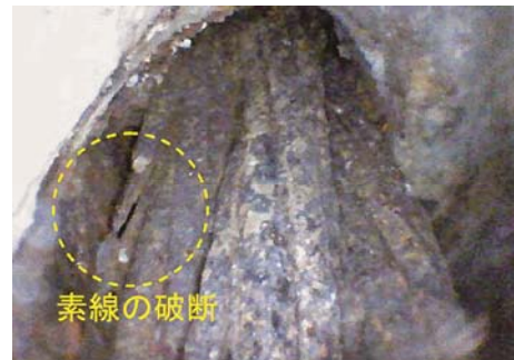
写真-5 P1付近のドリル削孔によるシース内の状況
