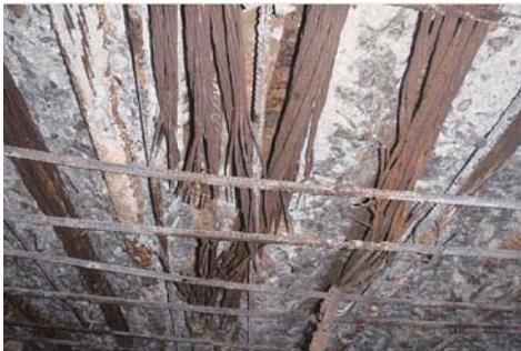
写真-4 A1-P1間現場打ち部の下床版下面はつり状況
