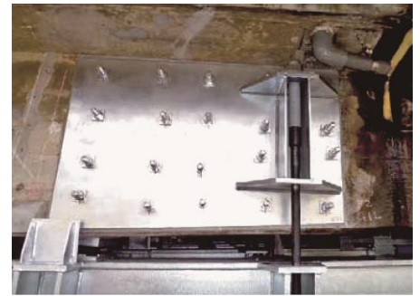
写真-3 ヒンジ部補強完了状況
