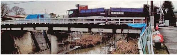
写真-4 荷重車両による静的载荷試験
