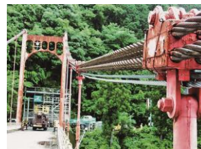
写真-4 セーフティケーブル設置状況
