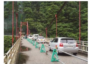
写真-5 通行止め解除状況
