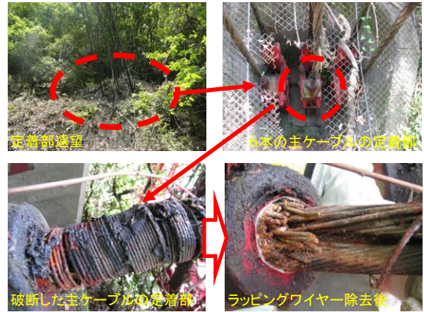
写真-1 主ケーブル破断状況
