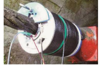
写真-3 全磁束法による腐食状況調査
