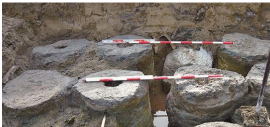
写真-1 改良体確認状況
