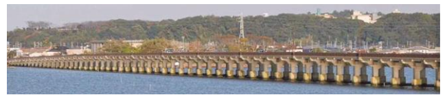
写真-1 神宮橋の全景
