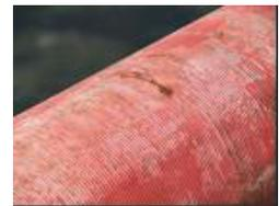
写真-7 主ケーブル防食工の劣化の例
