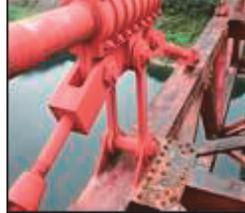
写真-4 ケーブルバンドとボルト 写真-5 鋼棒やピンの例
