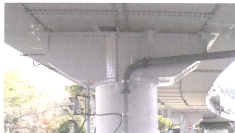
図-5 ブラケット補強 (P15橋脚)
