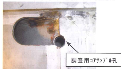
図-6 横梁ウェブ上端のスカラップ施工
