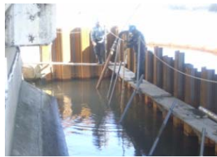
写真-3 流動化処理土工
