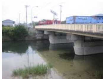
写真-1 稲村橋全景
