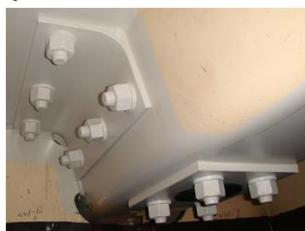
写真-2 き裂部の当て板補強の施工状況
