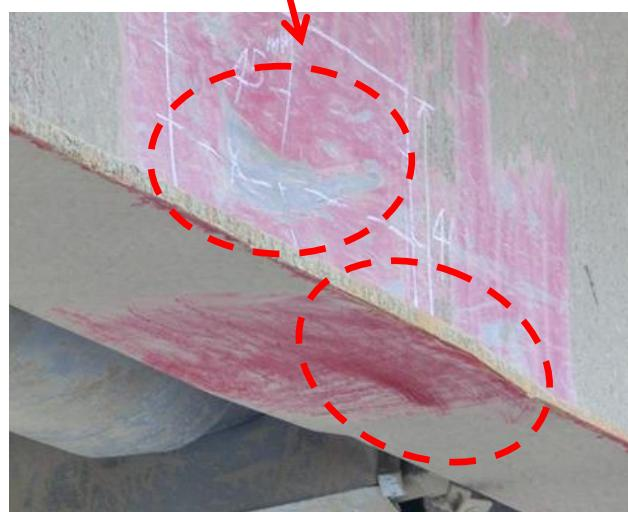
写真- 1.5.11 上流側鋼桁外側の状況（補剛材・ウェブ・フランジの変形）
