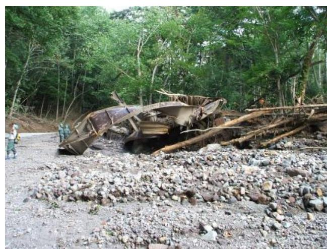
写真- 1.4.6 流失した丸駒橋の側道橋桁
