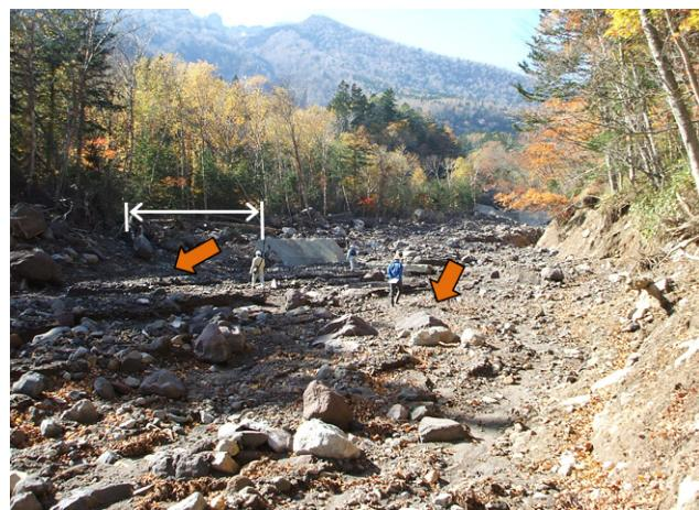
写真- 1.4.2 治山堰堤右岸側の土石流流下跡と同齡一斉林
