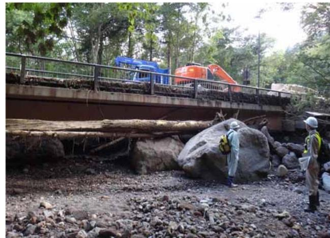
写真- 1.4.8 湖水橋桁下の土砂堆積状況（上流から撮影）
