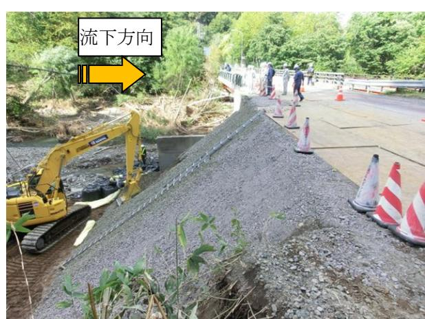
写真- 1.5.45 A2 橋台背面盛土の復旧状況
