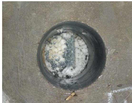
d) 孔内状況（内型枠：発泡スチロール）
