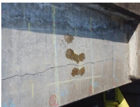
写真 4-17 G10 桁側面 No. 3
