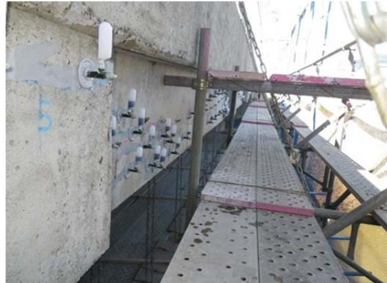
n) 主桁ひび割れ注入工
