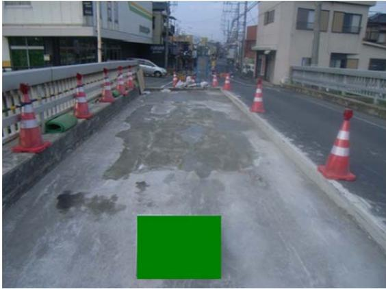
e) 桁上面の剥離部断面補修
