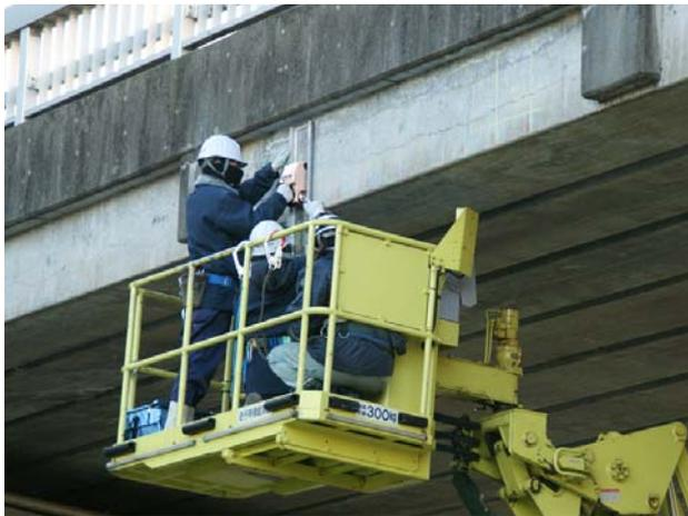
(3) 磁気計測ユニットによる磁束密度測定
