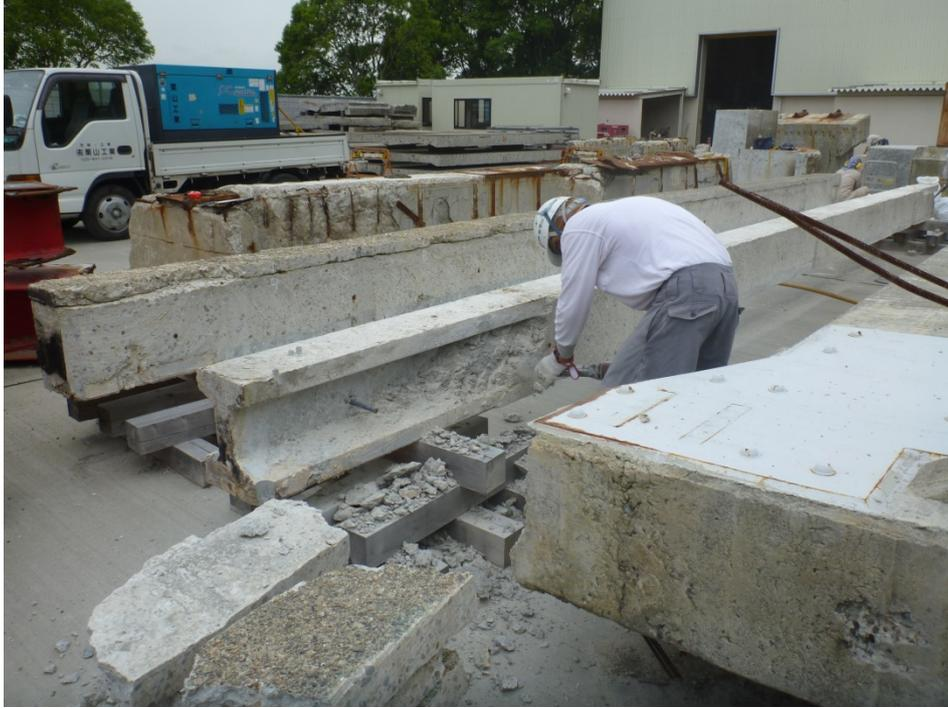
写真- 2.4 はつり状況 (G6 桁)
