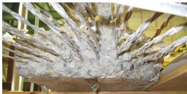
b) G3 桁 6 断面付近 (はつり調査)
