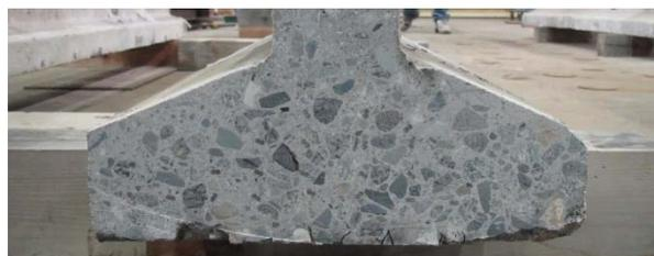
d) G3 桁 22' 桁切断面 (下フランジ)
