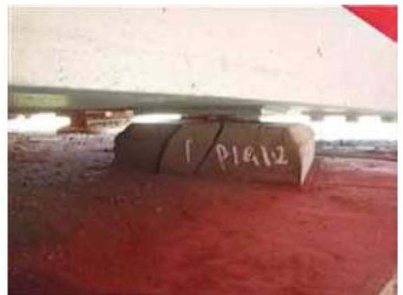
写真-4.2.16.5 P1 橋脚部の可動側変位制限
