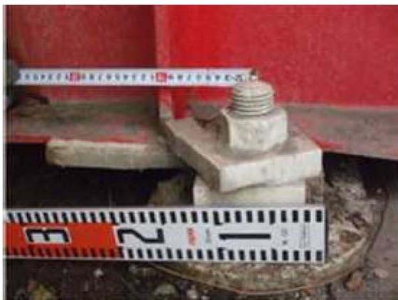
写真-4.2.16.4 A1 橋台部 G3 可動支承ピンチ
