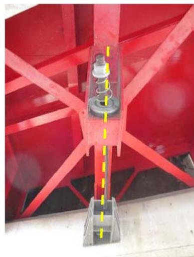
写真-4.2.16.12 橋台に取り付けられた落
