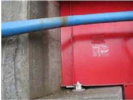
写真-4.2.16.2 A1 橋台部 G3 主桁遊間異常
