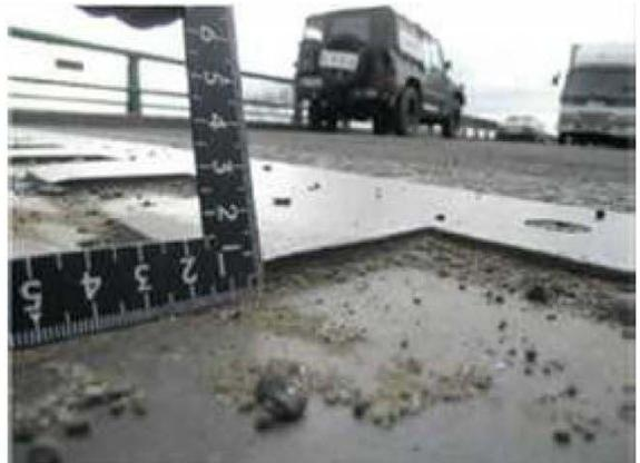
写真-4.2.16.7 A2 橋台部の伸縮装置の段差
