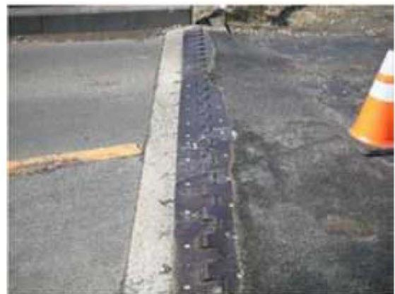
写真-4.2.16.6 A1 橋台部の伸縮装置の
