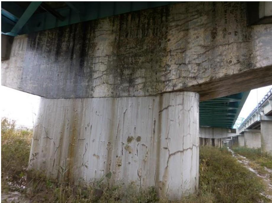
写真-2.1.3 ASRにより損傷した橋脚
