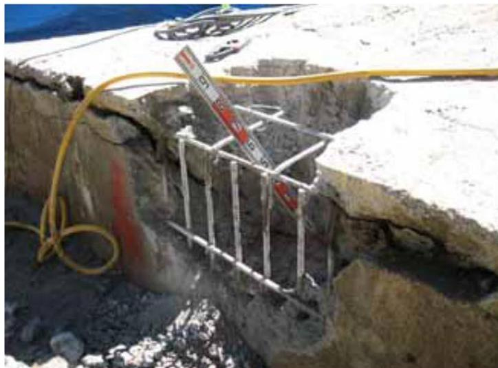
写真-2.1.1 ASR によりフーチングの上面鉄筋が破断した例<sup>1)</sup>
