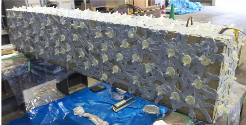
写真-4.3.1 ひび割れ補修の施工状況
