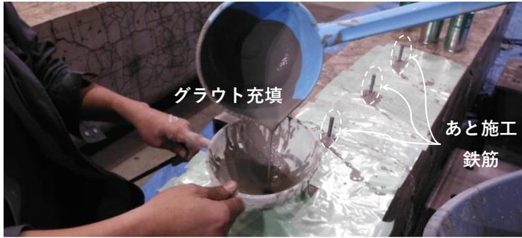
写真-4.3.3 せん断補強の施工状況
