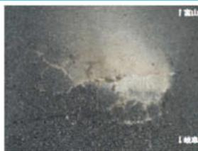
舗装のひびわれと土砂噴出跡
