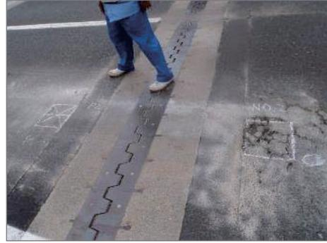
写真-3. 更新時に横断方向に排水パイプ設置後、ひび割れのため撤去。防水の不連続あり
