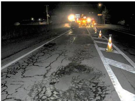
写真-1. 路面As舗装に網目状の無数のひび割れ・補修痕（主に走行位置）
