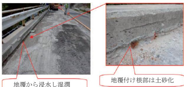
写真-8 土砂化状況（治部坂橋）
