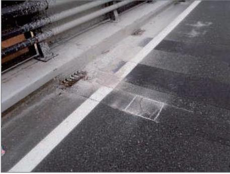
写真-1. 白い噴き出し。過去に全面的舗装・防水施工。下面是グレーチング床版。
