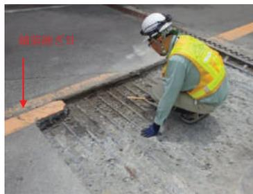
舗装の継ぎ目(センターライン)での床版土砂化
