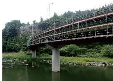
写真-4 大規模な仮設足場の設置事例
