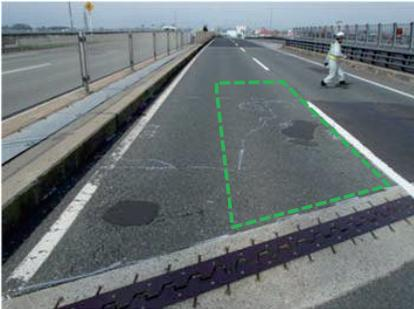
写真-1. 路面As舗装の補修痕から土砂噴出し
