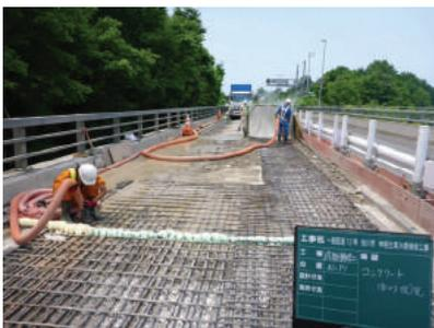
床版コンクリート打設完了
