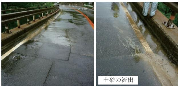
写真-9 舗装面に生じた変状（第一横岳橋）
