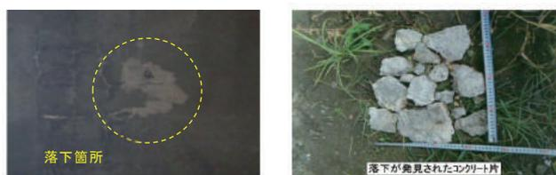
(a) 床版下面の落下部位 (b) 落下したコンクリート片
