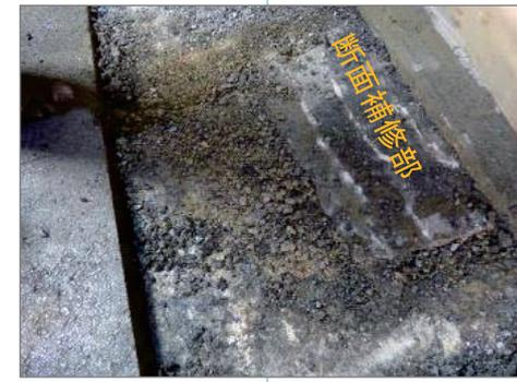
写真-3. 過去の床版上面補修箇所は浮き、周辺では土砂化
