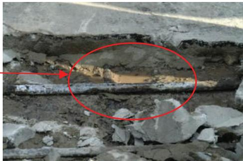
土砂化部以外のはつり箇所についても、鉄筋に腐食が見られた
