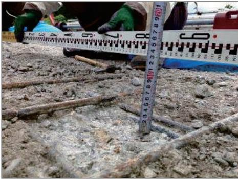
写真-2. 土砂化は上面鉄筋まで達する
