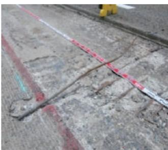
写真2 砂利化(鉄筋露出)
