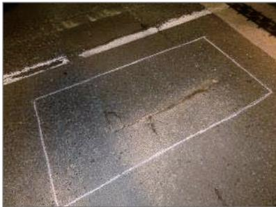
写真-1. 路面As舗装から土砂噴出し
