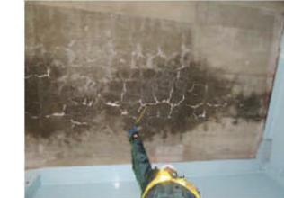
床版下面の詳細近接目視・打音(漏水、角落ち等確認)、車両通行時のひび割れ挙動の確認。
