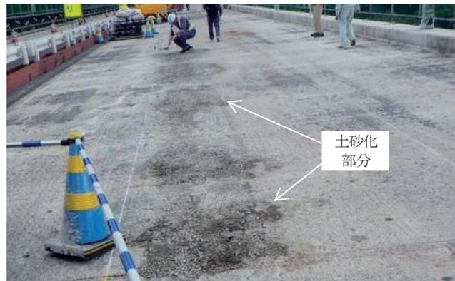
写真-2.4 舗装打継目付近下の床版コンクリートの土砂化
