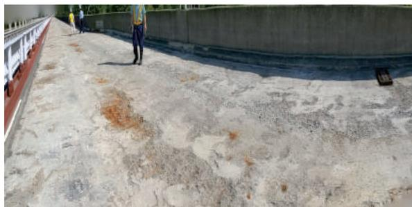
写真-1 舗装開削後の土砂化が進行した事例
