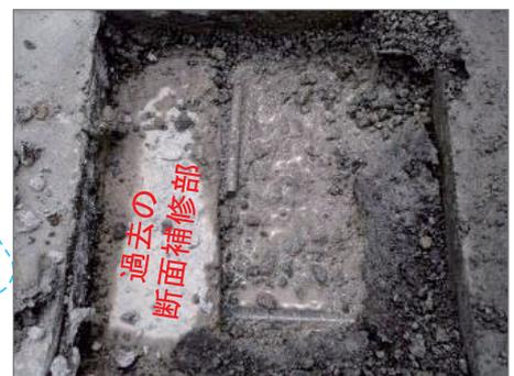
写真-4. 過去の補修隣接部の劣化
