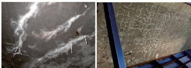
a) 漏水・遊離石灰                      b) 格子状のひび割れ
