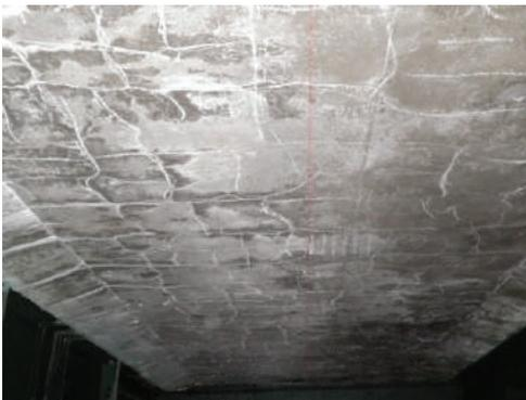
剥落、鉄筋露出
