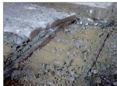
写真-3. 床版上面の滞水・土砂化
