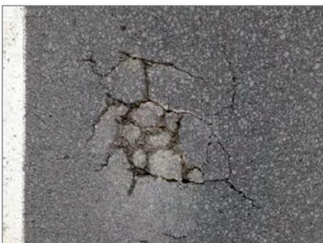
写真-2. 路面As舗装(近接) 土砂を含んだ噴き出し
