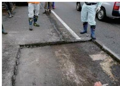
写真-2. 舗装と防水面の間に滞水。
