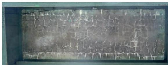
写真-1 床版下面の遊離石灰
