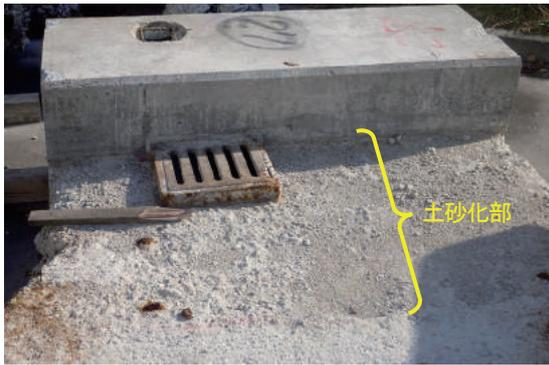
図-2 地覆、排水口付近の土砂化の事例 (Ka橋)
