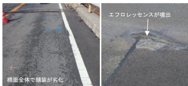
写真-4 舗装面に生じた変状（治部坂橋）
