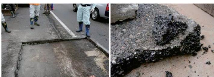
写真-3. 4. 床版面に異常なし。アスファルトは劣化（骨材剥離・もろい。約20年経過）
