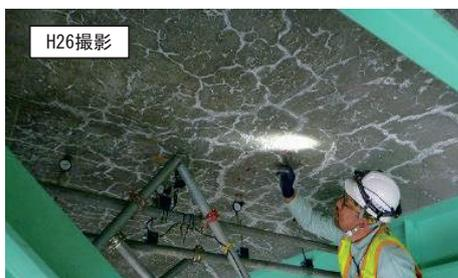
写真-2 床版打替対策後の床版下面の損傷状況（治部坂橋）
