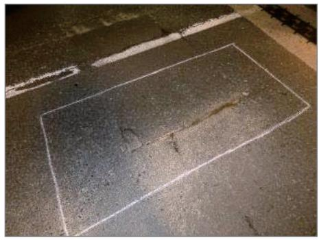
写真-1. 過去に床版上面補修した路面As舗装に土砂混じりの噴き出し
