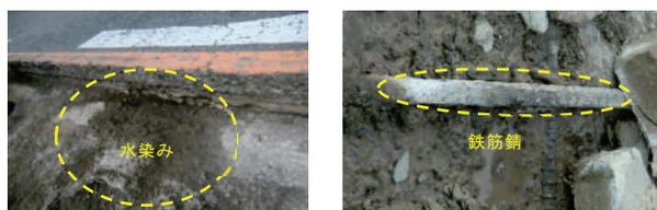
(a) 防水層下の水染み (b) 床版鉄筋の錆
