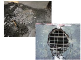
土砂化した床版（左）と舗装の抜け落ち（右）
