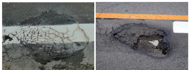
写真-2 床版上面(橋梁上の舗装)の異常
