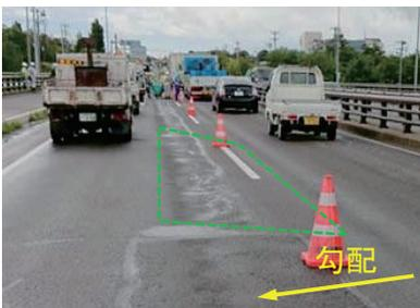
写真-1. 第1車線は右タイヤ部に路面ひび割れ
