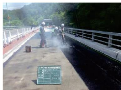
写真-14 塗膜系防水施工
