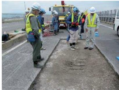
写真-2. 舗装ポットホール箇所以外でも広く土砂化が進行
