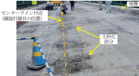
(a) 橋面アスファルト舗装を全面剥がした状況<sup>1)</sup>
