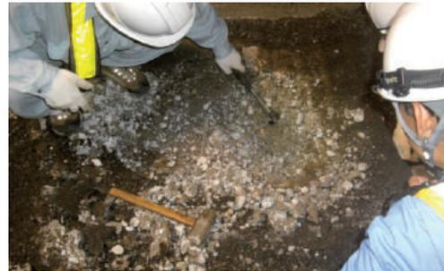
(b) 鉄筋が露出するまで工具で掘れる状態
