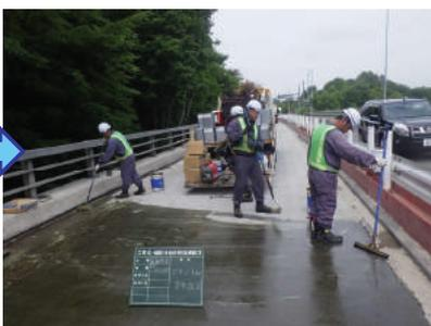
塗膜系防水施工
