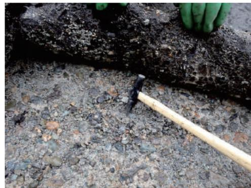
図-5 防水層下の土砂化の事例 (T橋)
