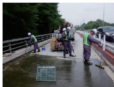
写真-13 浸透系防水施工
