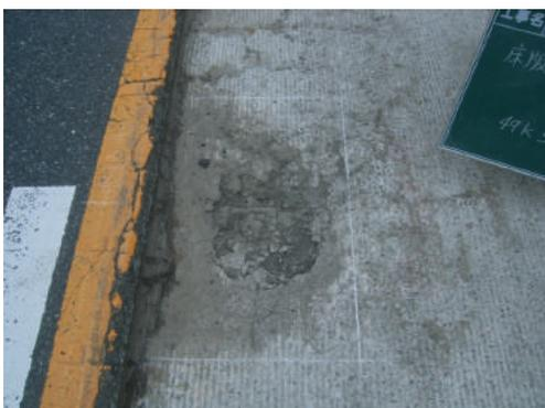
土砂化、鉄筋露出
