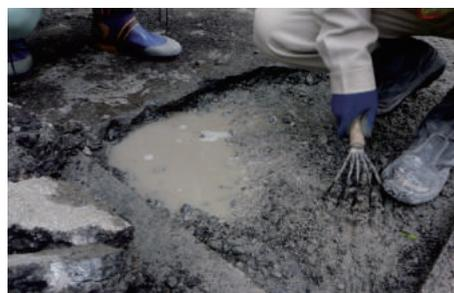
写真-11 土砂化状況（第一横岳橋）
