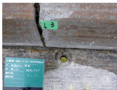
写真-12 水抜きパイプの追加設置
