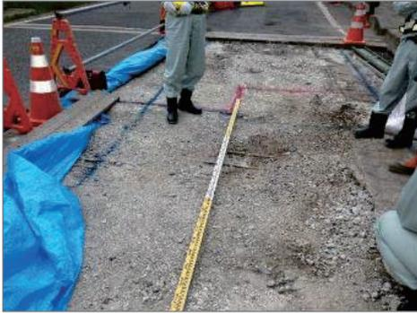
写真-1. 舗装補修時に舗装版撤去で広範囲の土砂化を確認
