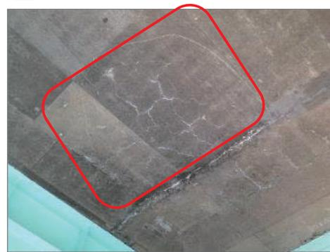
写真-3. 舗装異常個所の直下(横断方向ひび割れ・遊離石灰) 補修境界から遊離石灰。
