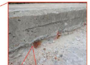
地覆付け根部分は土砂化
