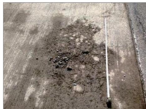
写真-4. (舗装撤去後)土砂化の深さは上面鉄筋まで達していない
