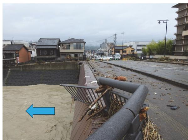
写真-3.1.101 防護柵の損傷（右岸下流側）
