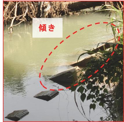
写真-3.2.44 護床工の変状状況
