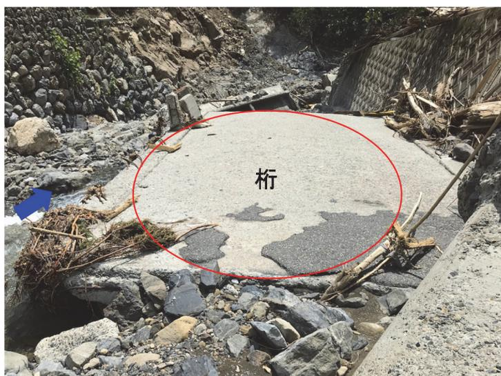
写真-3.2.3 桁の流出状況 (A1 側から撮影)
