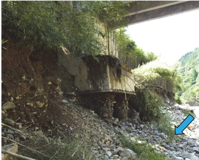
写真-3.2.24 A2 橋台基礎杭頭部の土砂流出
