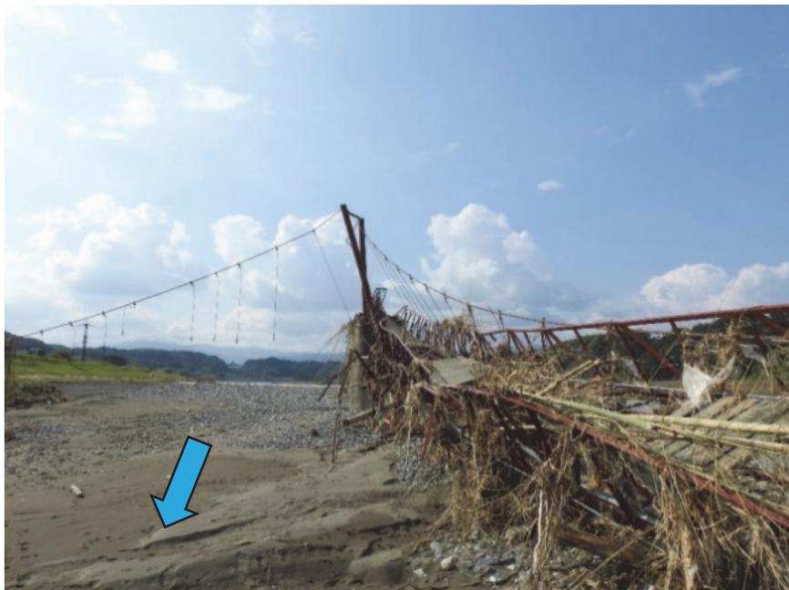
写真-3. 2. 30 右岸側側径間部及び中央径間部の被災状況
