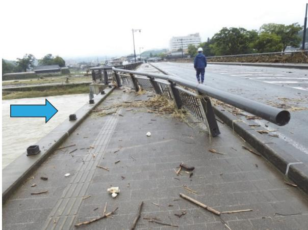
写真-3.1.100 防護柵の損傷
