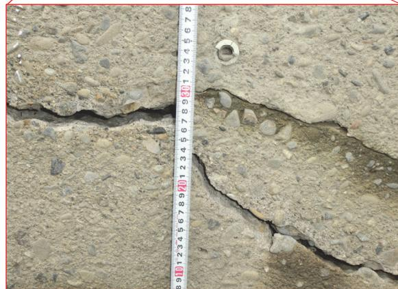
写真-3.1.74 P1におけるひび割れの状況
