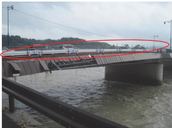
写真-3.1.108 応急復旧された防護柵
