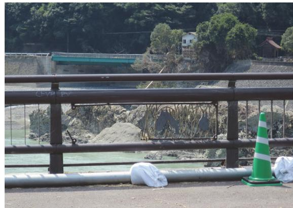
写真-3.1.52 左岸側径間の防護柵飾り柱部流出
