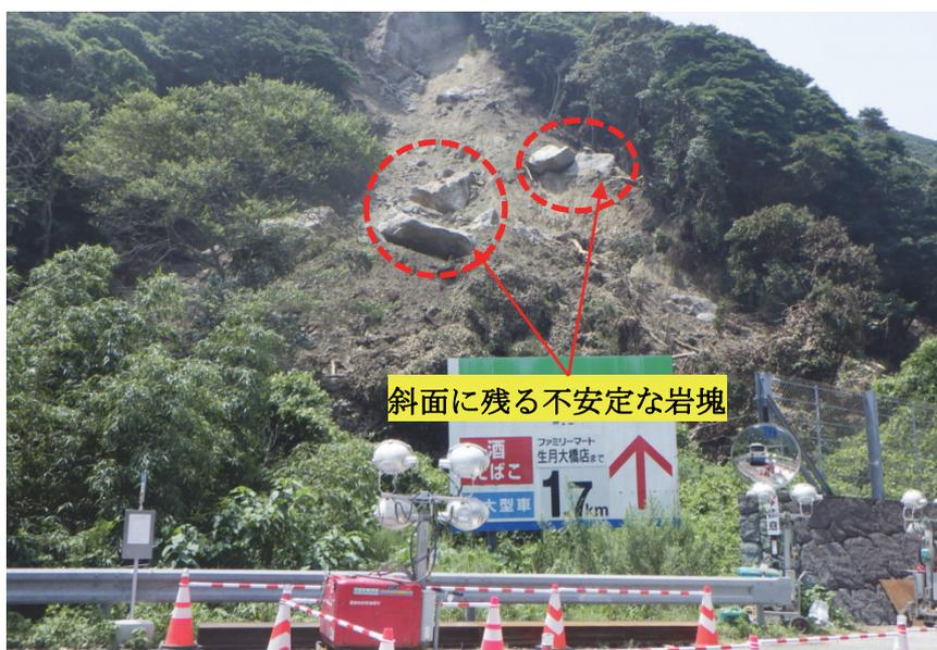
写真-4.2.9 斜面状況写真（8月4日撮影）
