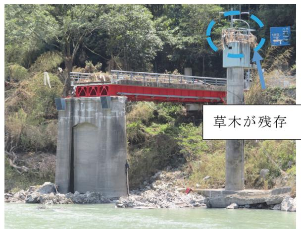
写真-3.1.61 A1～P1 間 残存する I 桁
