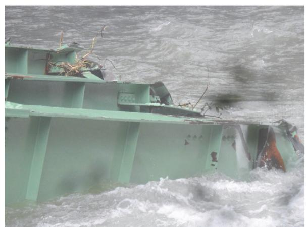
写真-3.2.39 流失した上部構造の支点部付近の変形
