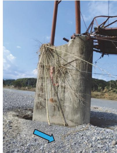
写真-3.2.32 右岸側橋脚基部周辺の洗掘
