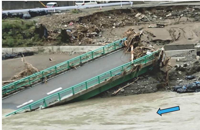
写真-3.1.15 流失した上部構造（鋼 I 桁橋）の状況
