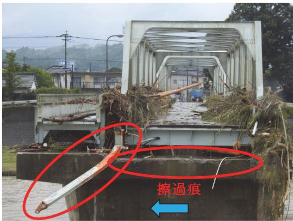
写真-3.1.92 P2 橋脚と上部構造の状態
