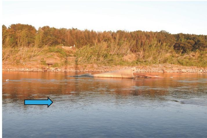
写真-3.2.33 転倒した左岸側橋脚主塔（11月13日撮影）
