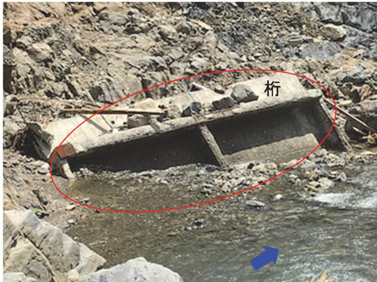
写真-3.2.4 桁の流出状況 (A1側から撮影)
