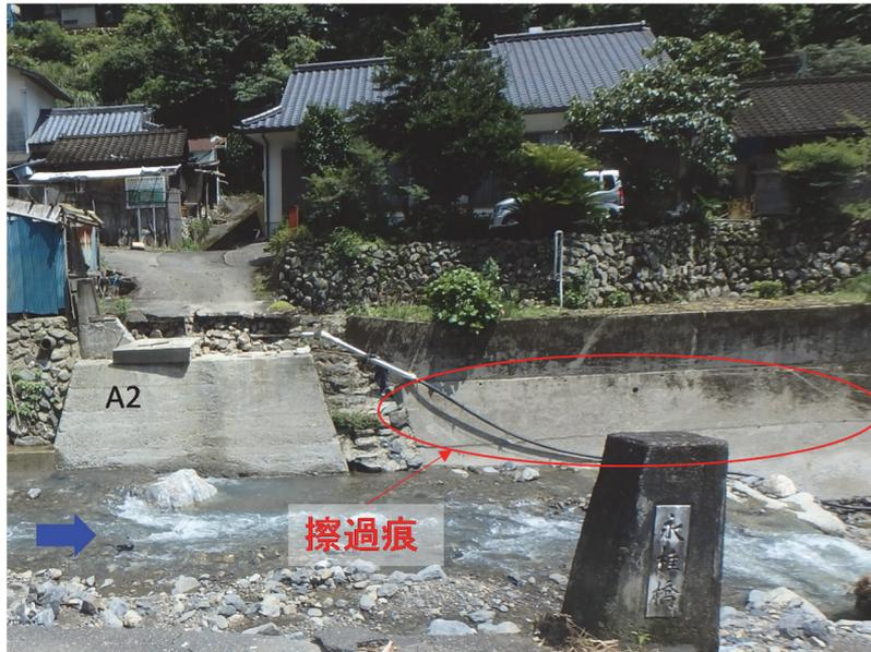
写真-3.2.10 下流側の擁壁の擦過痕（A1側から撮影）
