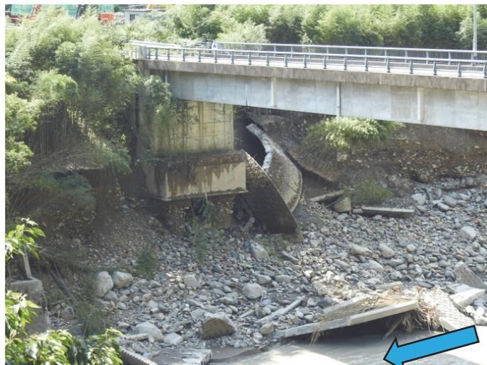
写真-3.2.26 A2 橋台盛りこぼし部の擁壁の沈下、倒壊及び土砂の流出
