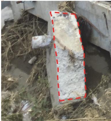
写真-3.1.27 A1 橋台パラペットのコンクリートブロック
