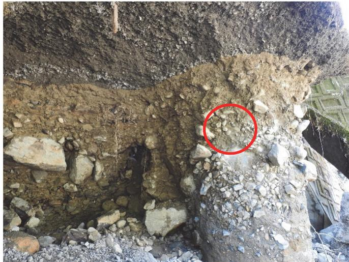
写真-3.2.25 A2 橋台の前列上流側の杭頭部の状態
