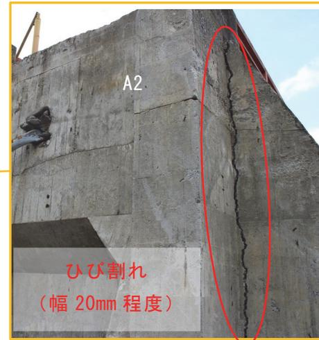
写真-3.1.84 A2 橋台背面側のウィング接合部のひび割れ
