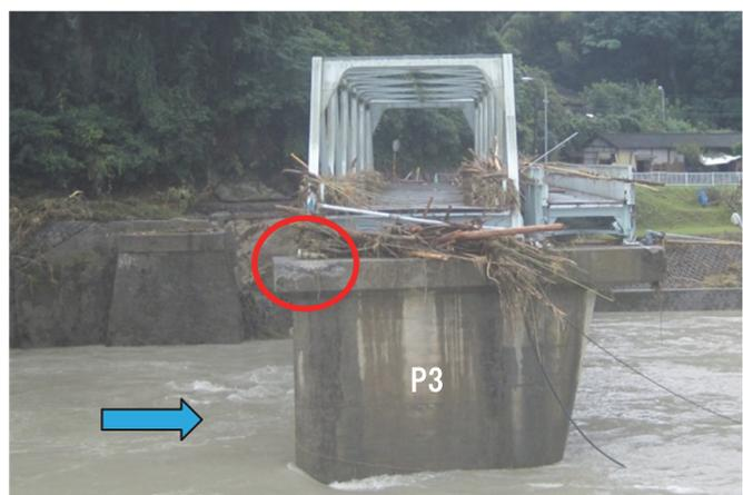
写真-3.1.95 P3 橋脚と上部構造の状況（7月10日撮影）
