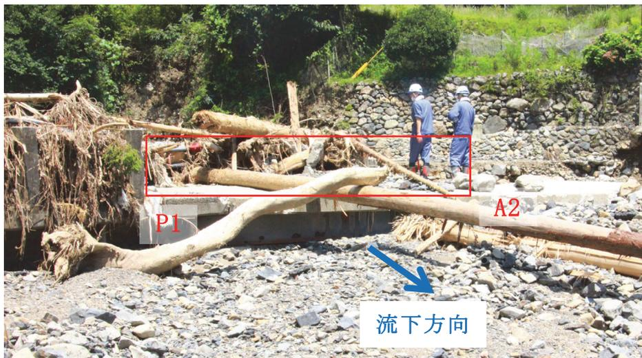
写真-3.2.14 下流側防護柵が流失した状況（P1～A2 間）
