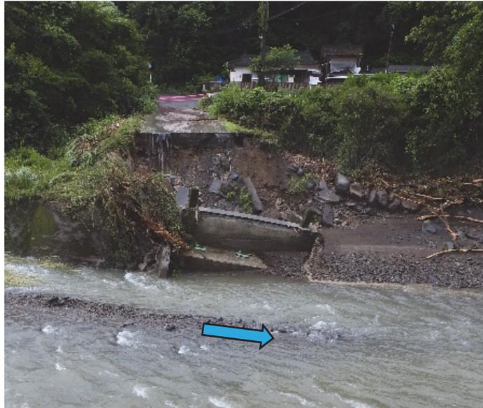
写真-3.2.37 沈下傾斜した A1 橋台
