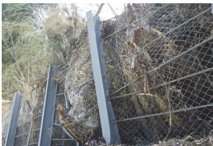
写真-4.2.8 落石防護柵 捕捉状況（8月4日撮影）
