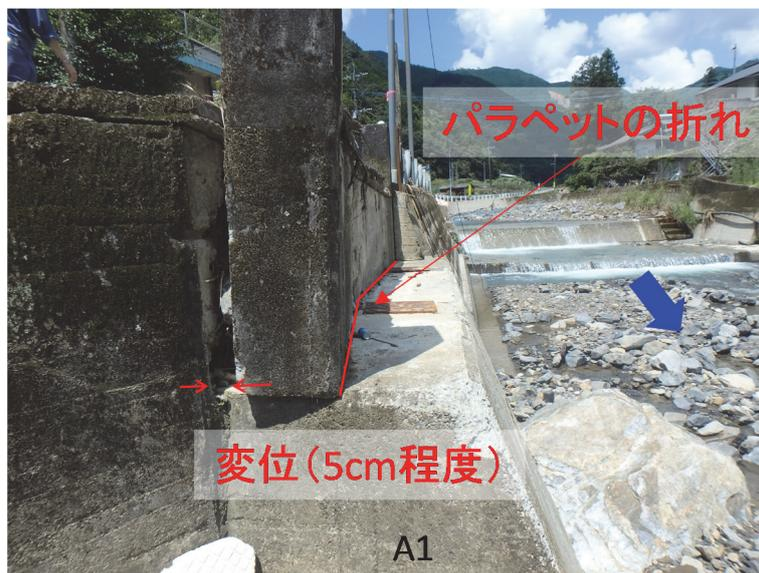
写真-3.2.5 A1橋台のパラペットの変状
