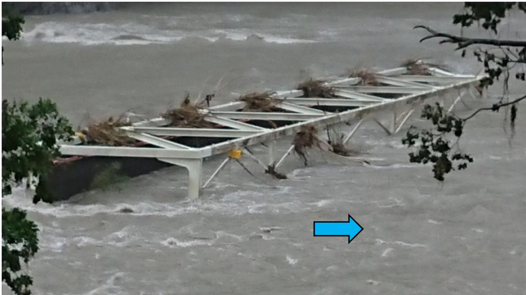
写真-3.1.34 流失した上部構造（トラス）の状況（架橋位置から約100m下流）
