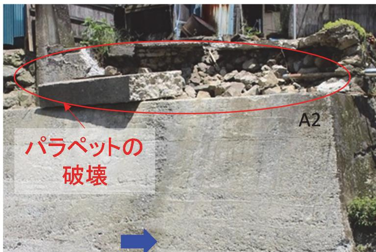
写真-3.2.6 A2橋台のパラペットの変状 (A1側から撮影)
