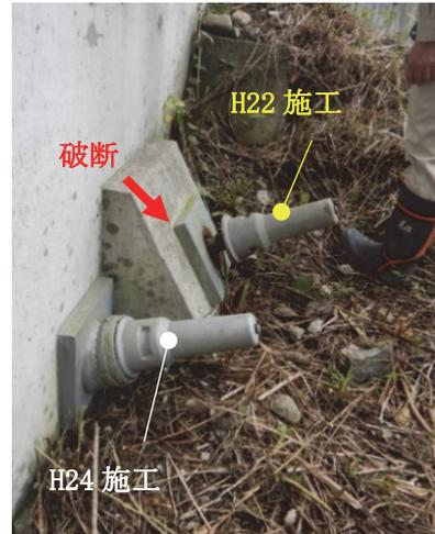
写真-4.3.4 アンカーの破断状況 (7月27日撮影)
