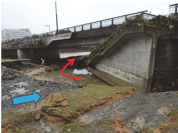
写真-3.1.106 階段部の回転・沈下・傾斜
