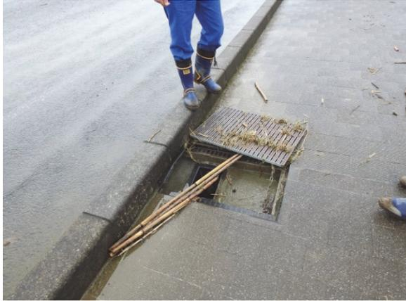
写真-3.1.104 排水溝の蓋の外れ
