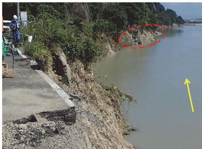
写真-4.1.21 崩壊地点より下流の地山の状態（7月30日撮影）
