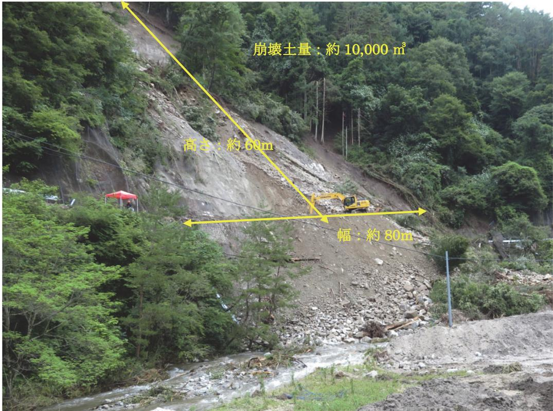
写真-4.2.1 被災状況写真 (7月15日撮影)
