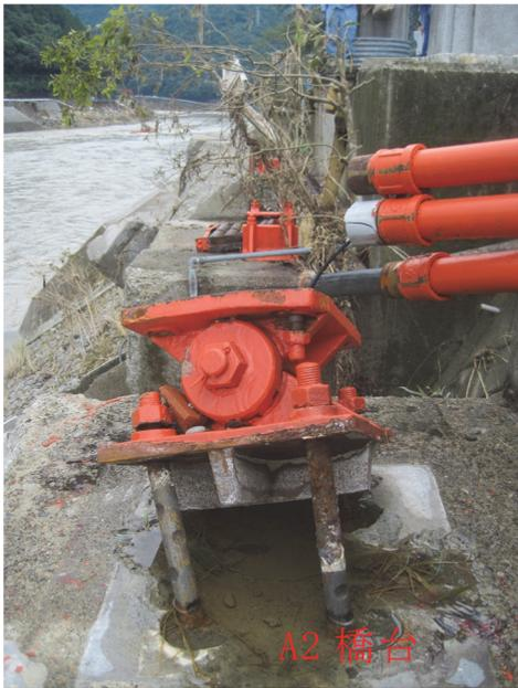
写真-3.1.9 側道橋 A2 支承部損傷
