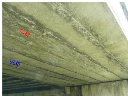
写真4.1.1 本橋桁下面のひび割れ状況
