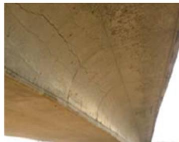
(桁側面に軸方向ひび割れが発生)
