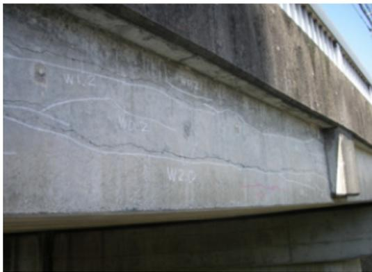
写真 6.2.1 外桁側面に発生した軸方向ひび割れ
