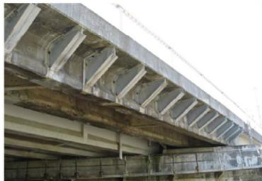
(塩害によりコンクリートの浮き, 剥離が発生)
