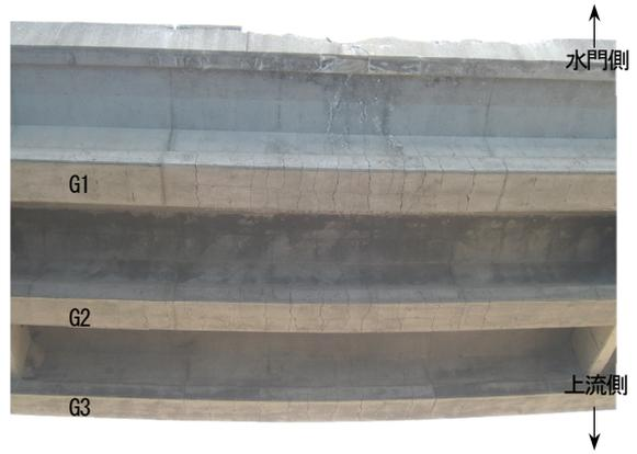
(b) 主桁に多数の曲げひび割れ
