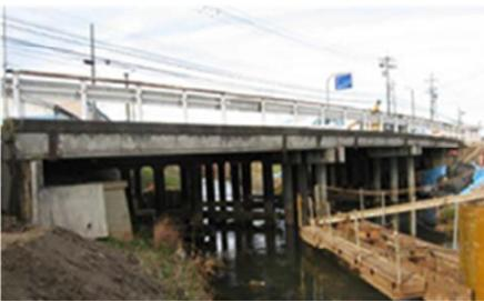
④相見川海浜橋 (1972年建設, PCT桁橋)
