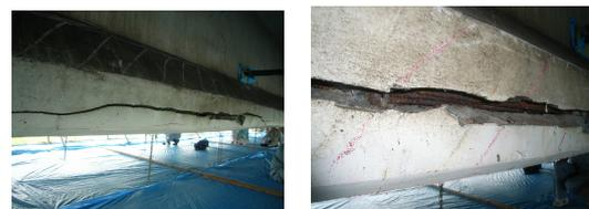
写真 3.1.2 PC桁下フランジ部の劣化状況
