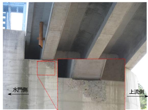
写真 5.1.3 橋座部の損傷状況 (第3径間)
