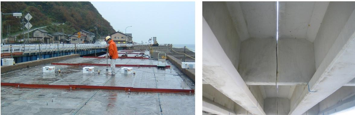
写真 6.1.3 主桁切断状態における振動測定の様子
