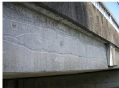
(桁側面に軸方向ひび割れが発生)
