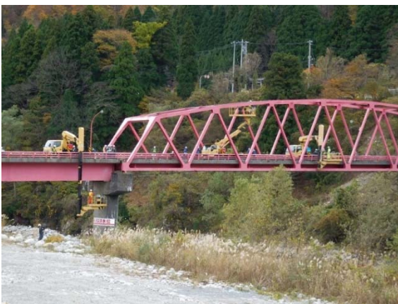
音沢橋外観（平成 29 年 11 月 22 日直轄診断の様子）
