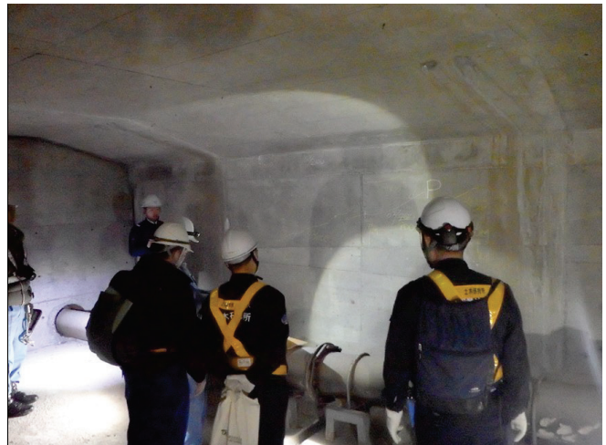
現地調査の様子（箱桁内）
