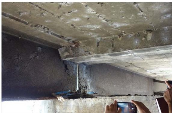
塩害により腐食損傷した鋼桁の様子
