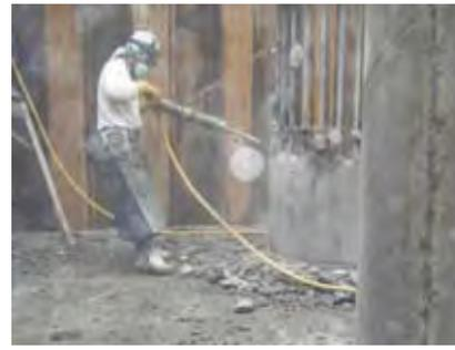
c) 外殻鋼管切断 (カッター)
