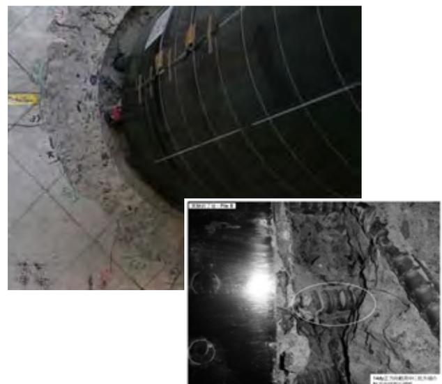
杭頭補強鉄筋の破断
