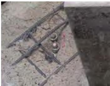
(d) フーチング上面での鉛直押抜きせん断破壊
