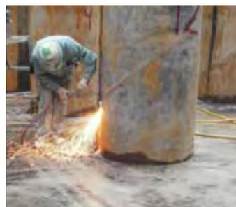
b) 外殻鋼管切断 (ガス溶断)
