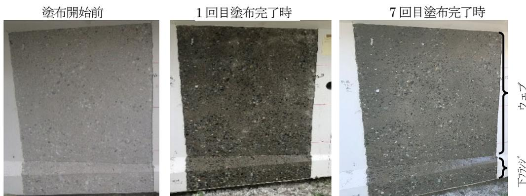
写真 4.3.2 含浸材塗布時の状況（桁端部）
