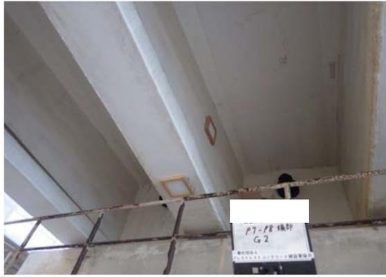
写真 2.5.2 ドライガーゼ法の調査状況（暴露状況全景）
