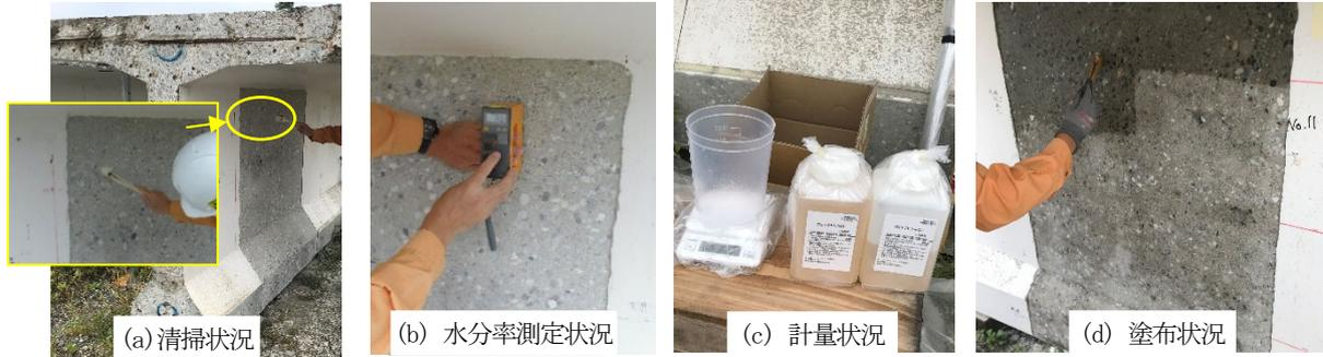
写真 4.3.1 含浸材塗布作業状況
