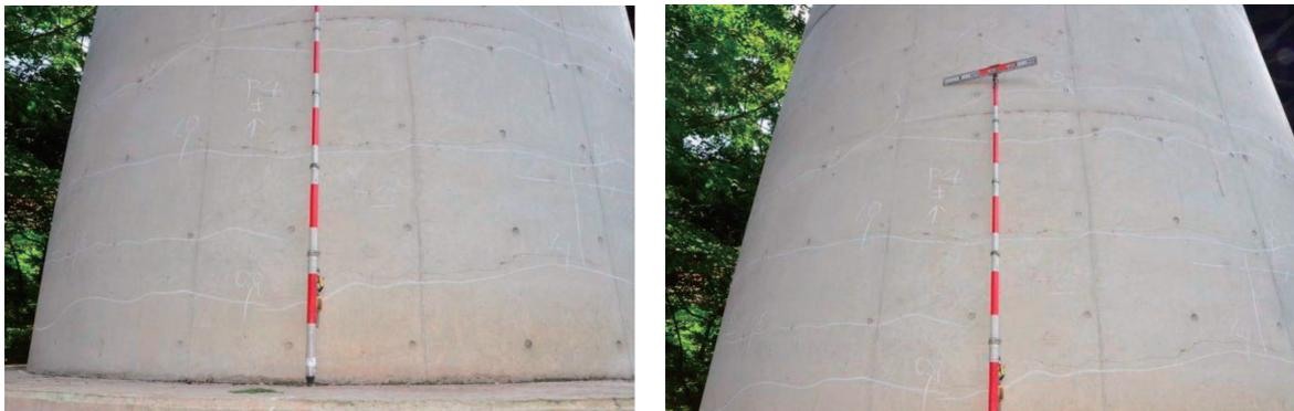
写真-2.3.16 P4 橋脚の損傷状態
