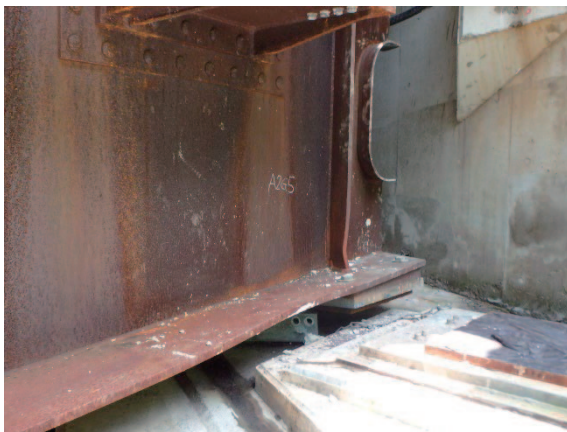
写真-2.3.17 A2 橋台の支承の損傷状態(その2)
