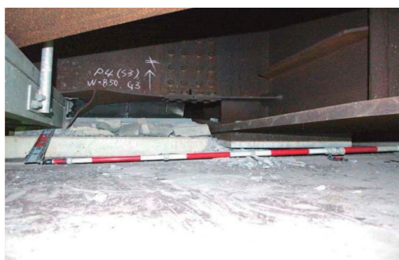
写真-2.3.15 P4 橋脚の支承の損傷状態(その 1)
