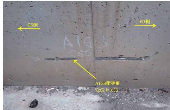
(a) 橋台胸壁のひび割れ及び剥落 (左：G1側，中央及び右：G5側)
