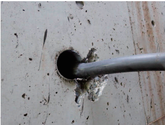
(d) G4 部の落橋防止ケーブル
