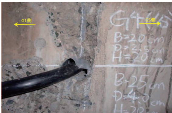
写真-2.3.20 落橋防止ケーブル貫通穴の損傷状態(その1)
