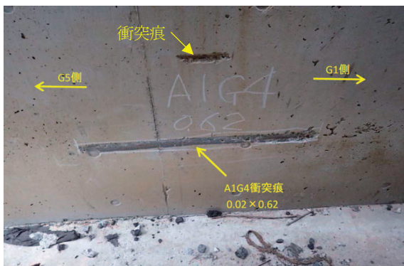
(b) 橋台胸壁に生じた衝突痕
