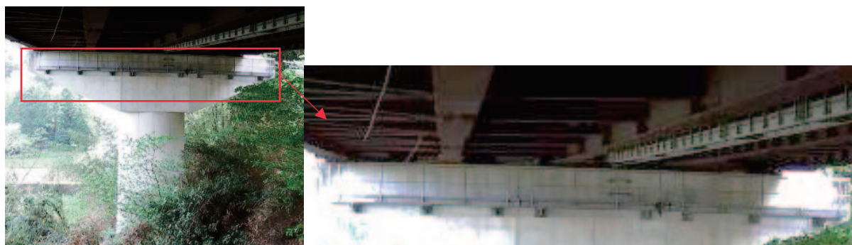
写真-2.3.6 P1 橋脚全景 (4/17, A1 側から撮影)
