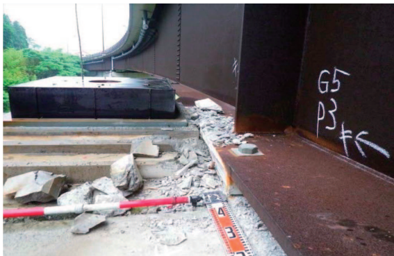
写真-2.3.12 P3 橋脚の支承の損傷状態(その2)
