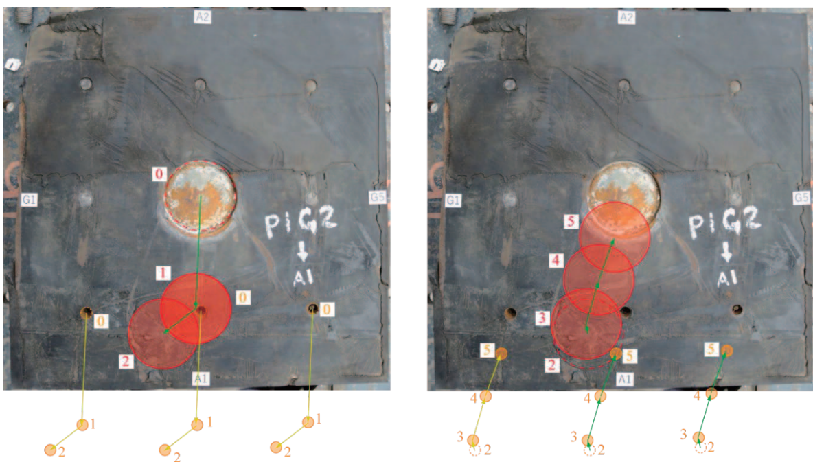
図-2.4.4 考えられるせん断キー及び上沓取付ボルトの動き(PIG2)
