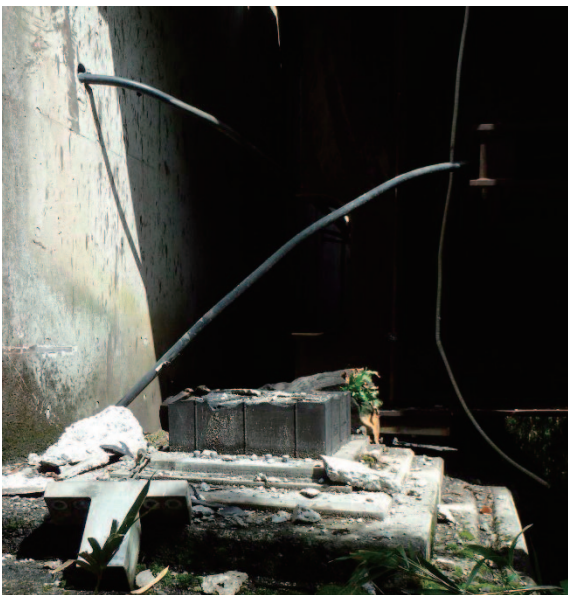
(e) G5 の落橋防止ケーブル
