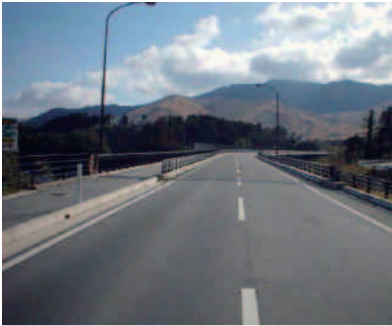
(b) 橋面 (A1 橋台)
