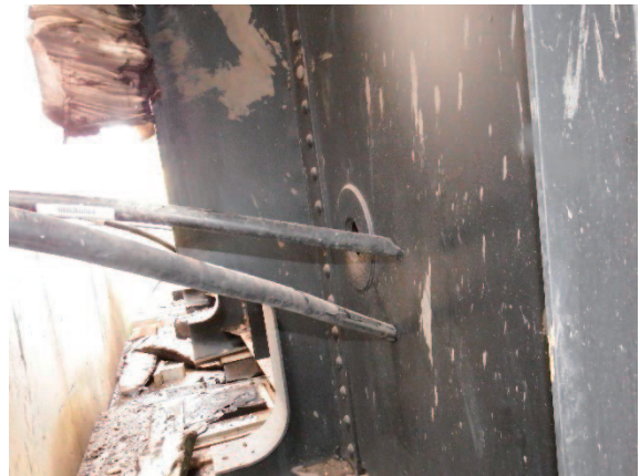
(d) G4 部の落橋防止ケーブル
