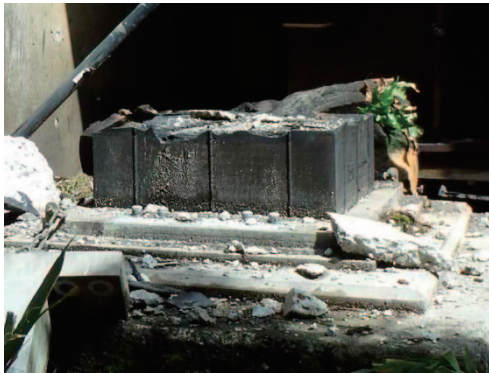
写真-2.3.3 A1 橋台支承の損傷状態(その2) (サイドブロック損傷写真の提供：九州地方整備局)
