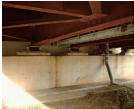
(c) 橋台及び支承 (A1 橋台)
