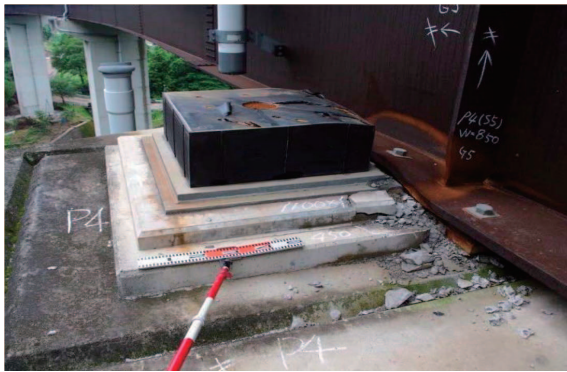
写真-2.3.15 P4 橋脚の支承の損傷状態(その2)
