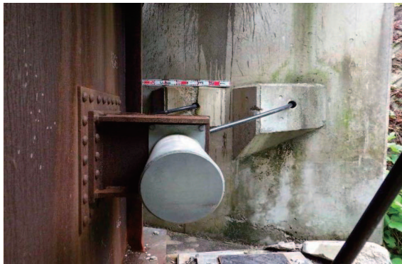
写真-2.3.18 A2 橋台の落橋防止ケーブルの損傷状態(その2)
