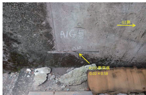
(b) 橋台胸壁に生じた衝突痕
