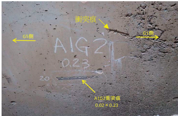
(a) 橋台胸壁のひび割れ及び剥落 (左：G1側，中央及び右：G5側)
