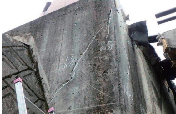
(a) 橋台胸壁のひび割れ及び剥落 (左：G1側，中央及び右：G5側)
