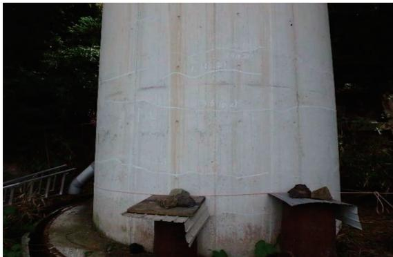
写真-2.3.8 橋脚の損傷状態(起点側)
