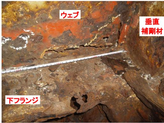
図 3-12-4 桁端部の腐食と断面欠損<sup>32)</sup>
