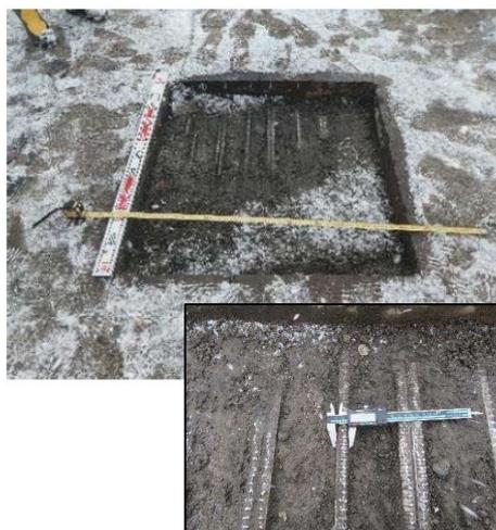
図3-3-6 土砂化による変状例
