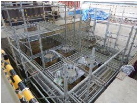
付写真-2.2.55 打設完了-01
