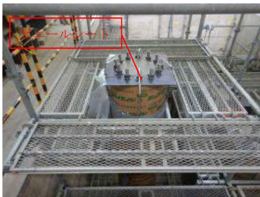
付写真-2.2.57 現場封緘養生
