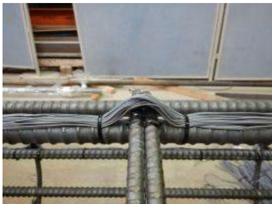
付写真-3.1.16 リード線の配線
