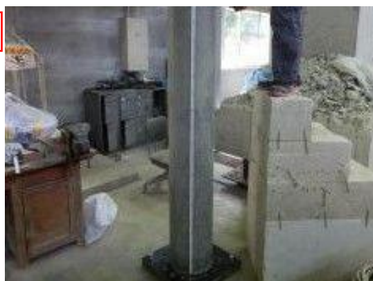
付写真-4. 2. 82 杭供試体の延長計測
