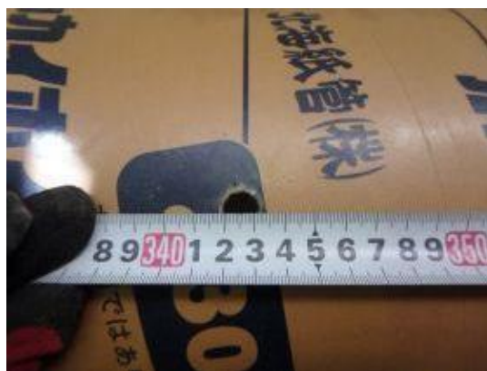
付写真-4.2.60 孔明け位置 (ボイド管下端から)
