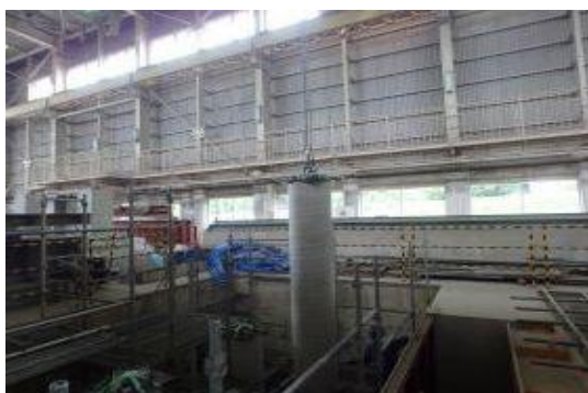
付写真-2.2.59 供試体の吊り出し状況
