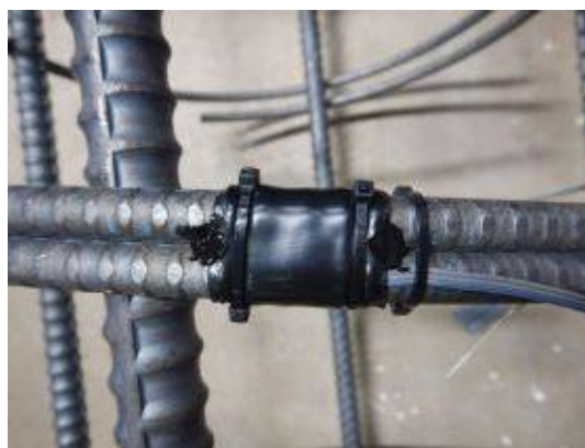
ロックタイを用いて VM テープの両端を防水結束
