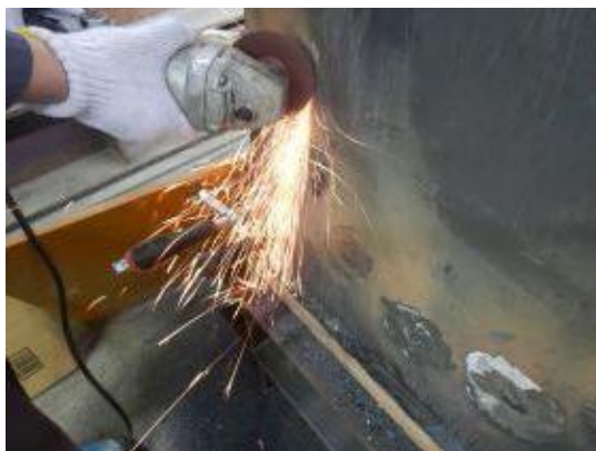
付写真-3.1.10 シール溶接部の平滑化处理
