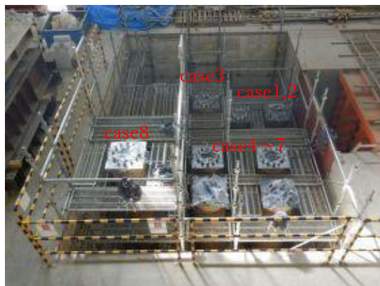
付写真-2. 2. 43 供試体 8 体分の型枠設置完了
