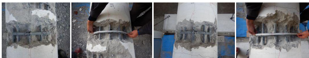
写真-4.2.5.5 3H 継手部のはつり調査状況
