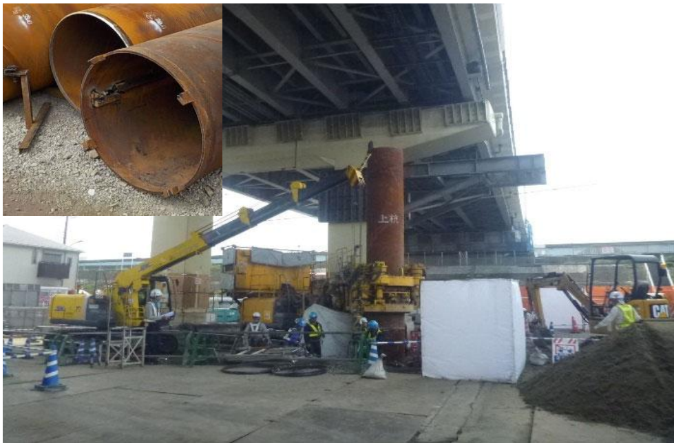
写真-7.2.2.3 鋼管杭施工状況（左上：先端ビット）
