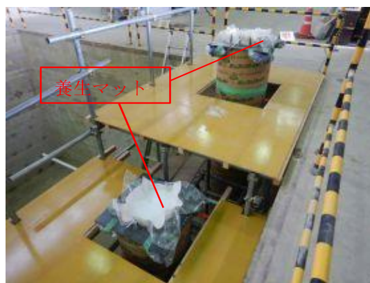
付写真-3.1.45 現場封緘養生
