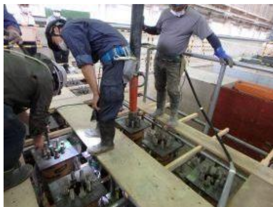
付写真-4. 2. 76 打設状況-04
