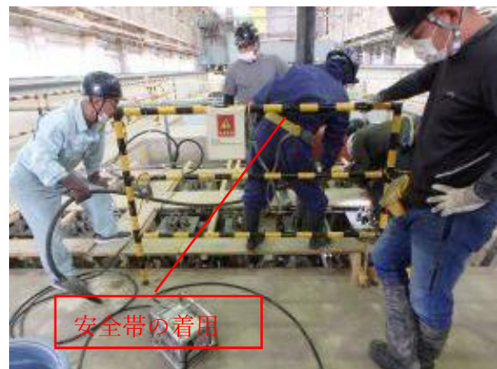
付写真-4. 2. 74 打設状況-02
