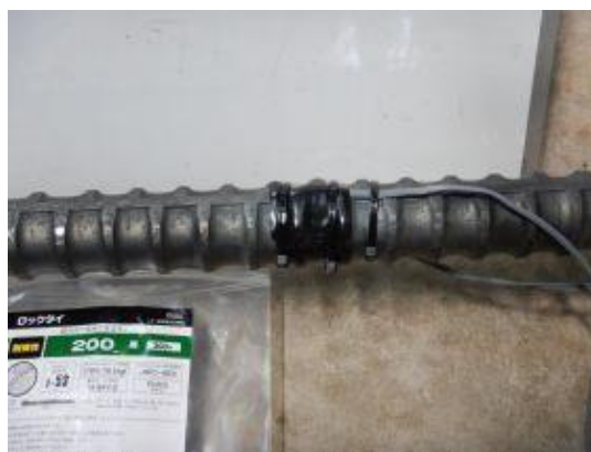
付写真-2.2.20 ロックタイを用いてVMテープの両端を防水結束
