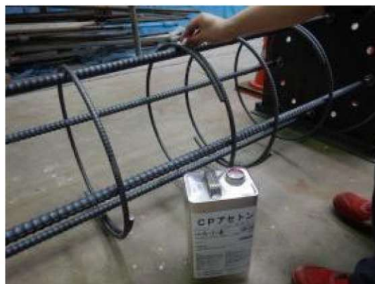
付写真-3.1.12 アセトンによる脱脂
