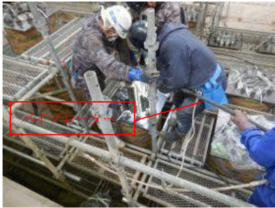
付写真-2.2.53 打設状況-03
