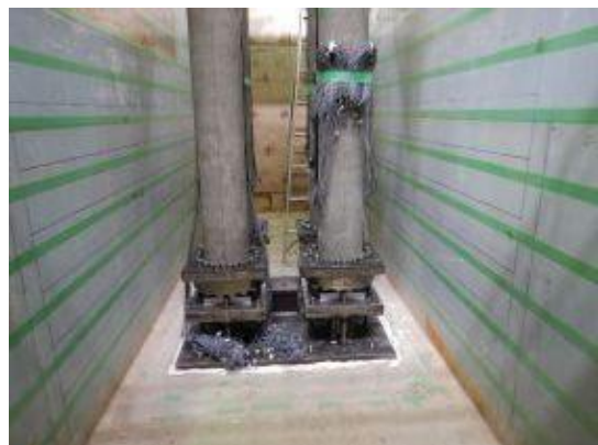
付写真-4.2.133 杭供試体の設置
