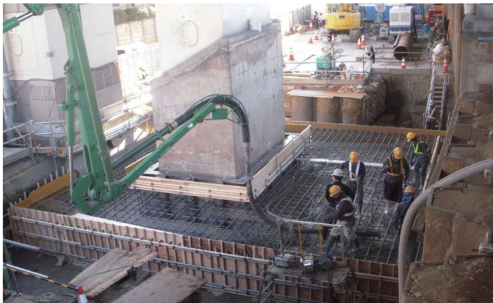
写真-7.2.2.2 増厚補強と鋼管矢板基礎の増し杭補強状況
