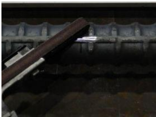
付写真-2.2.14 貼付け範囲の黒皮除去
