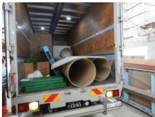
付写真-3.1.20.1 ボイド管の荷受け
