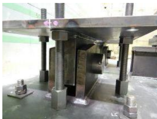
付写真-4. 2. 128 押しボルト 4 点にて仮固定
