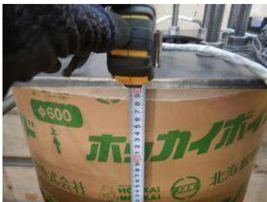
付写真-3.1.28 case1 用型枠延長の確認
