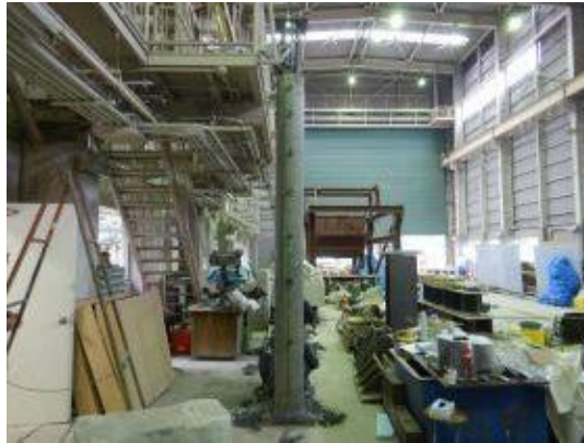
付写真-4.2.93 三軸ゲージの設置
