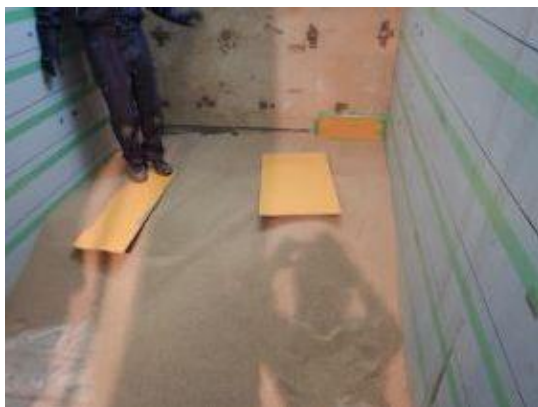
付写真-4. 2. 181 パネコートの作業足場板
