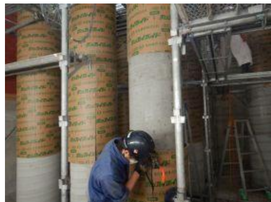
付写真-2.2.58 脱型状況
