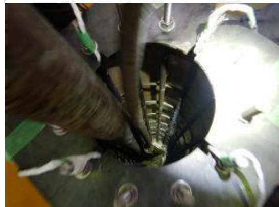
付写真-3.1.43 打設状況-02
