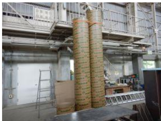
付写真-3.1.20.2 ボイド管の建て起こし
