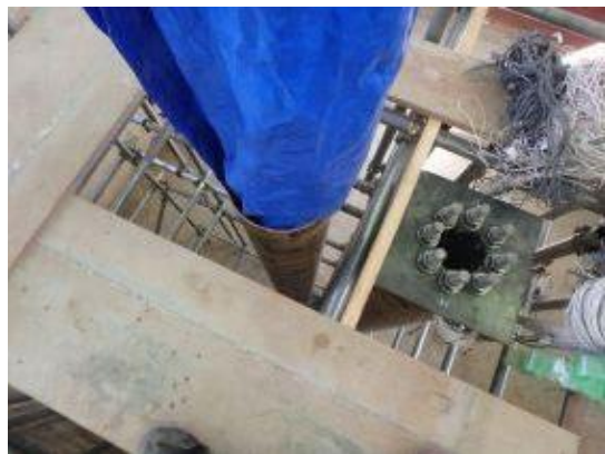
付写真-4. 2. 64 型枠材のボイド管の設置
