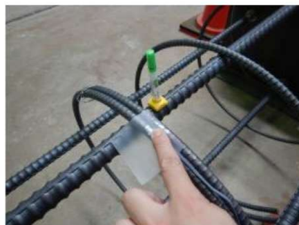
付写真-3.1.13 ひずみゲージの貼付け・加圧
