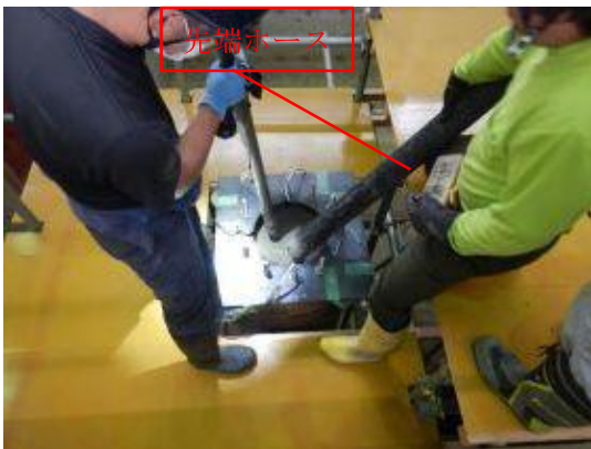
付写真-3.1.42 打設状況-01
