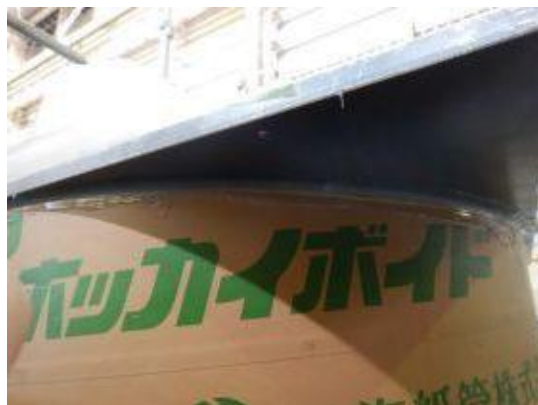
付写真-2. 2. 42 打設口側 BP のシーリング
