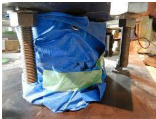
付写真-4. 2. 174 ブルーシートの設置
