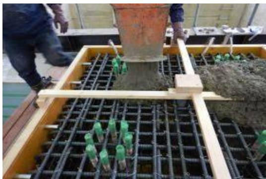
付写真-4. 2. 156 コンクリート打設
