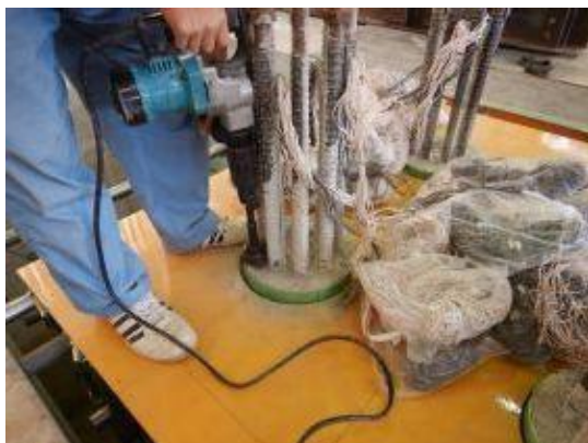
付写真-4. 2. 139 ビシヤンによる杭頭処理
