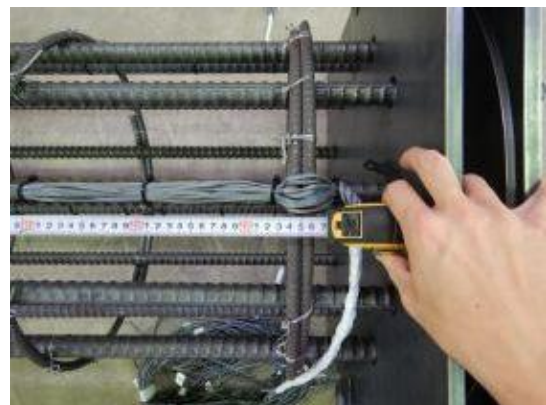
付写真-3. 1. 19. 2 配筋検査 (case2) 一部抜粋
