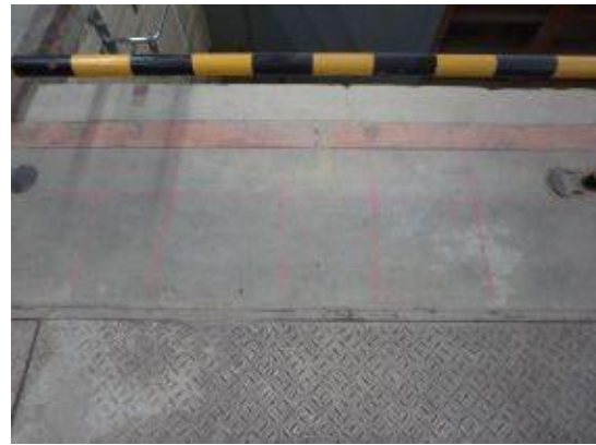
付写真-4. 2. 107 実験棟床面の配筋調査
