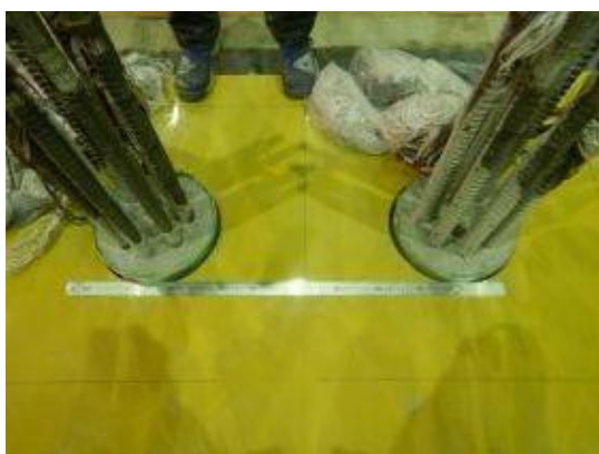
付写真-4. 2. 141 杭頭部での杭中心間隔の確認
