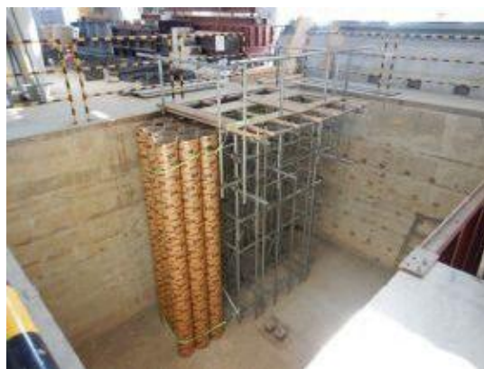
付写真-4.2.58 作業足場設置状況
