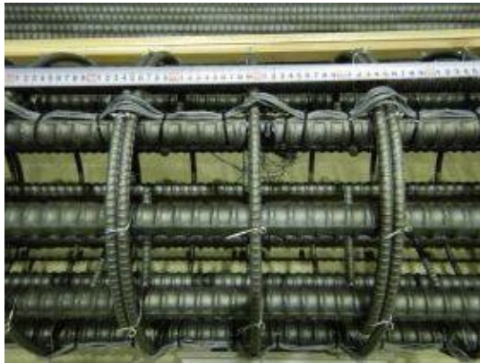
付写真-2.2.21 リード線の配線
