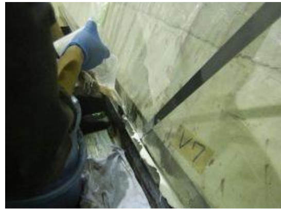
付写真-4. 2. 125 高強度石膏の流し込み
