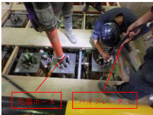
付写真-4. 2. 73 打設状況-01
