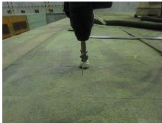
付写真-4. 2. 108 \phi 23\text{mm} \times 205\text{mm} の穿孔状況
