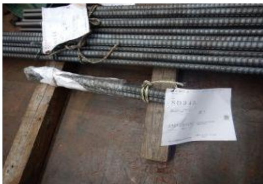
付写真-3.1.1 主鉄筋の荷受け状況
