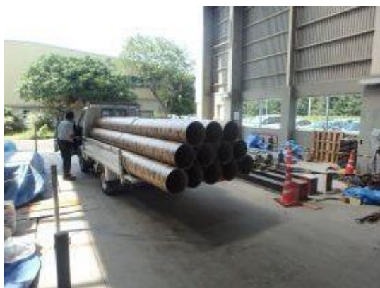
付写真-4.2.57 型枠材に用いたボイド管搬入
