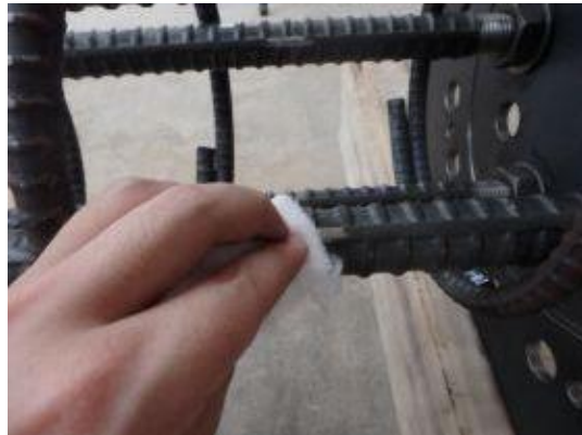
付写真-4. 2. 38 アセトンによる脱脂
