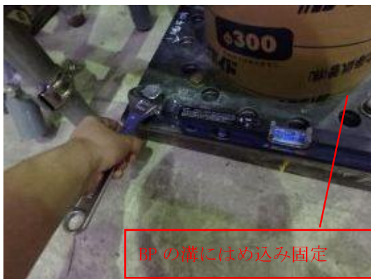
付写真-4. 2. 65 型枠底板四隅に設置した押しボルトにて型枠の立ち調整
