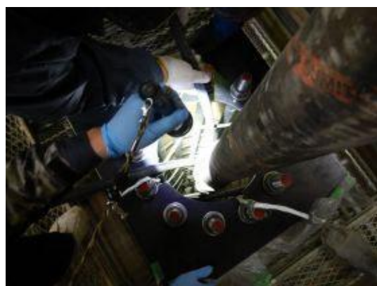
付写真-2.2.52 打設状況-02
