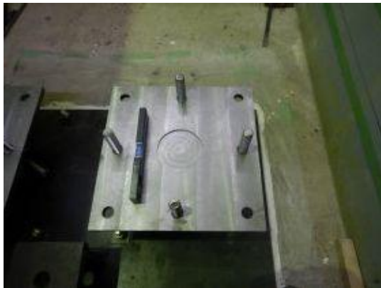
付写真-4. 2. 126 1 山クレビスの水平調整
