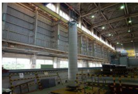
付写真-3.1.50 供試体の吊り出し状況
