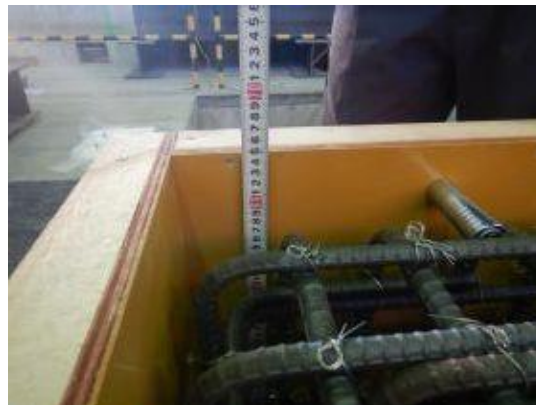
付写真-4. 2. 148 フーチング型枠検査（一部抜粋）
