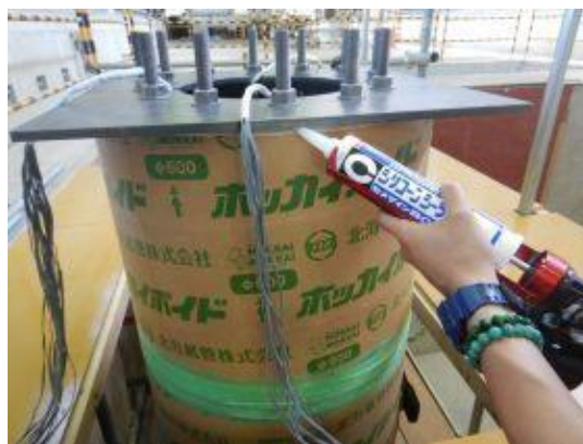
付写真-3.1.31 打設口側 BP 溝部のシーリング
