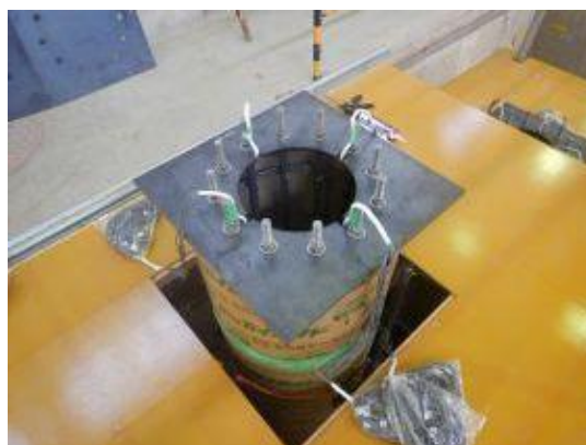
付写真-3.1.33 case2 設置完了
