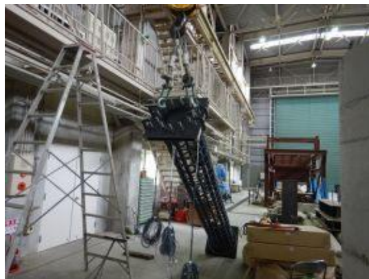
付写真-2.2.33 鉄筋かごの建て起こし
