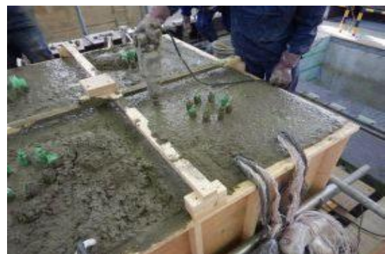
付写真-4. 2. 157 バイブレーターによる締固め
