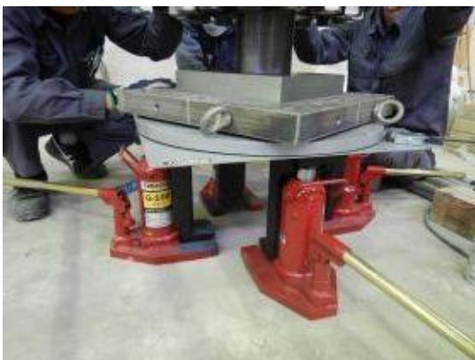
付写真-4.2.132 杭先端治具の設置
