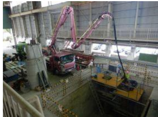
付写真-3.1.41 コンクリートポンプ車-02
