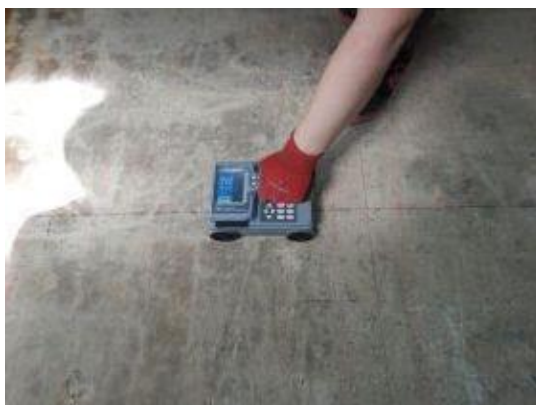
付写真-4. 2. 104 鉄筋探査状況
