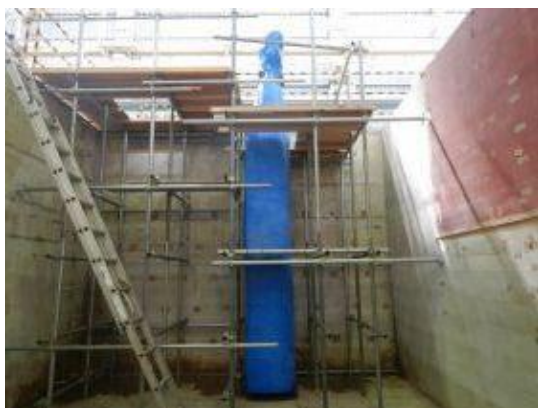
付写真-3.1.25 ブルーシートを用いて養生
