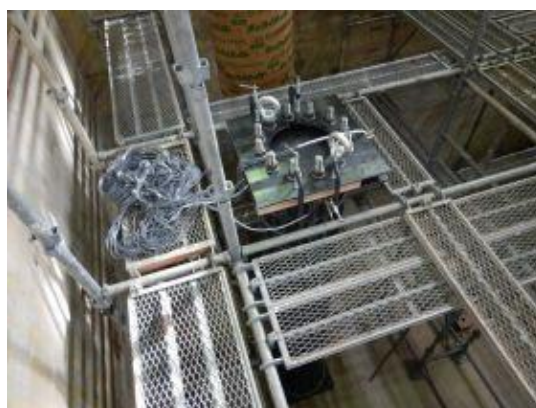
付写真-2.2.35 鉄筋かごの建て込み
