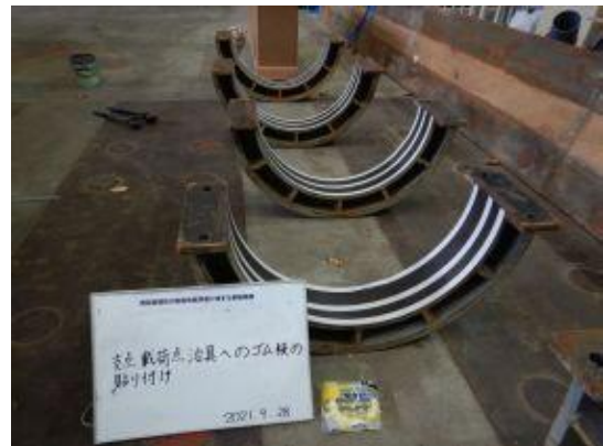
付写真-3.2.3 両面テープの設置
