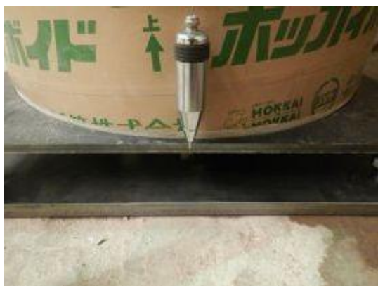
付写真-3.1.27 鉄筋かごの建ち確認
