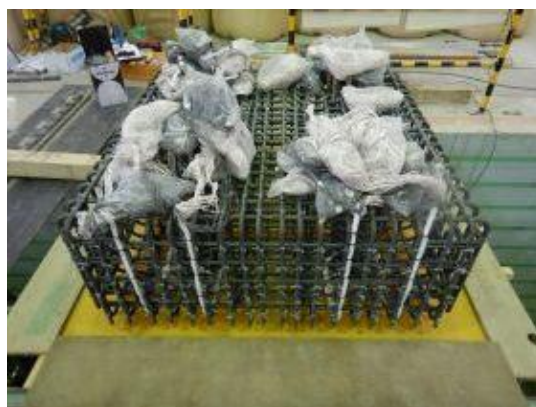
付写真-4. 2. 144 フーチング配筋完了
