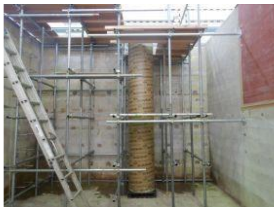
付写真-3.1.26 型枠材のボイド管の挿入
