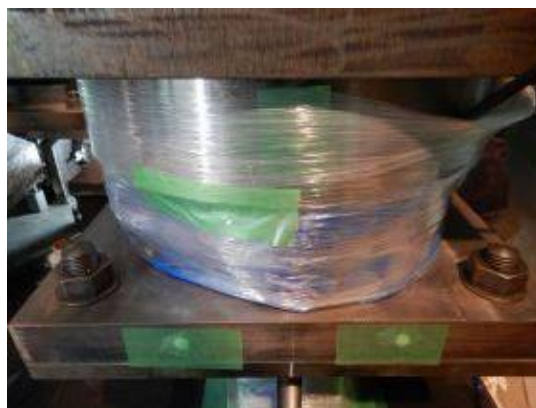
付写真-4. 2. 176 ロードセル部のラップ
