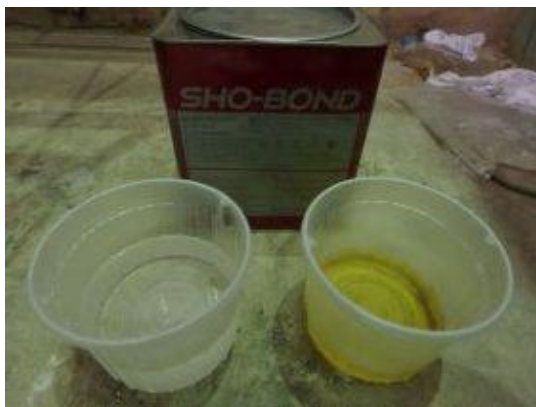
付写真-4. 2. 114 主剤・硬化剤の計量
