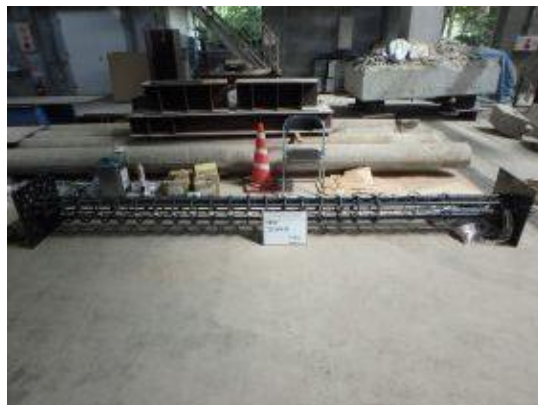
付写真-4.2.53 配筋検査 鉄筋かご 9 体目
