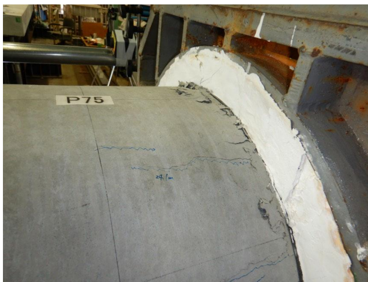
(b) コンクリート圧壊箇所
