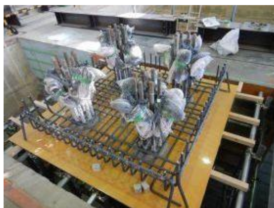
付写真-4. 2. 142 フーチング下側主鉄筋の配筋
