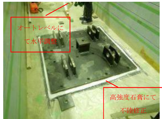
付写真-4. 2. 112 ベースプレートの設置
