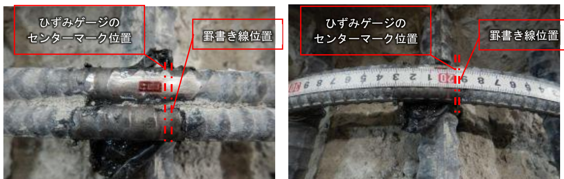
写真-4.2.5.7 3H 継手部はつり調査記録
