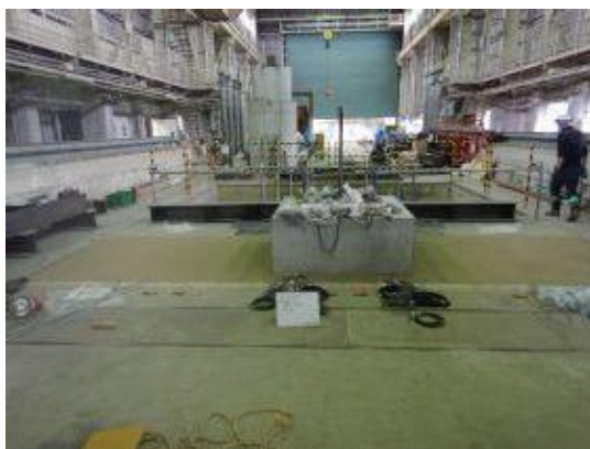
付写真-4. 2. 184 鹿島砂投入完了-01
