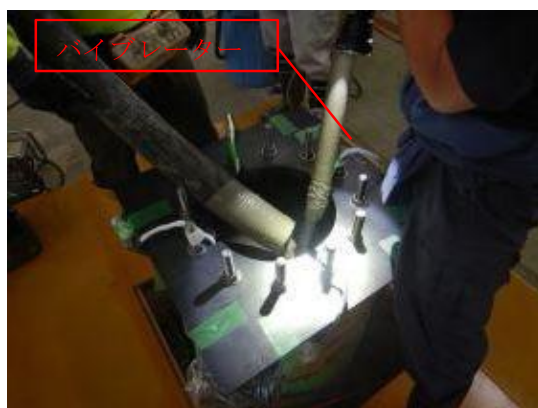
付写真-3.1.44 打設状況-03
