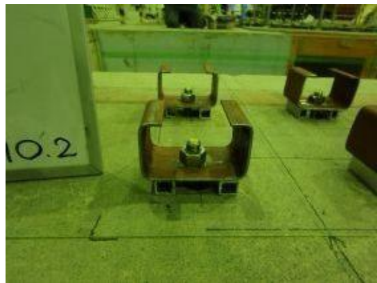
付写真-4. 2. 119 アンカーボルトの設置
