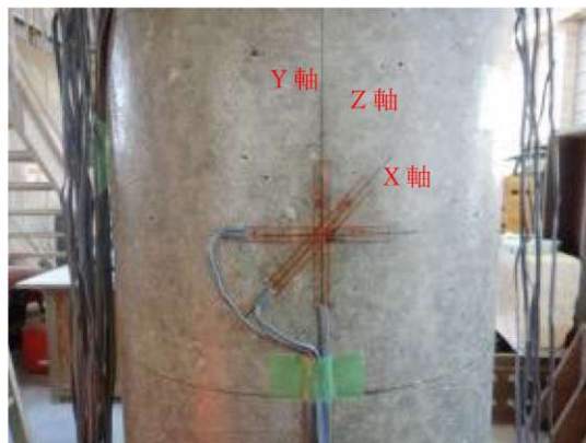
付写真-4.2.90 三軸ゲージの設置
