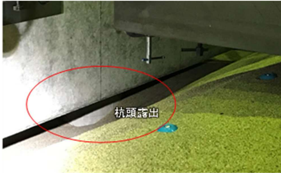
写真-4.3.1.2 実験中の様子(水平荷重200kN程度時)
