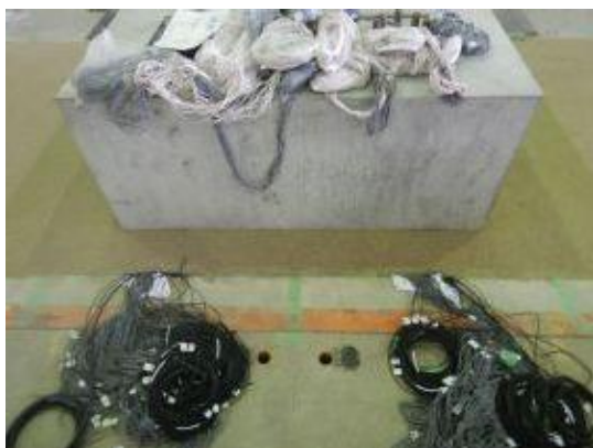
付写真-4. 2. 185 鹿島砂投入完了-02
