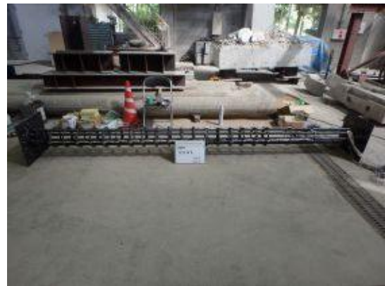
付写真-4.2.47 配筋検査 鉄筋かご 3体目
