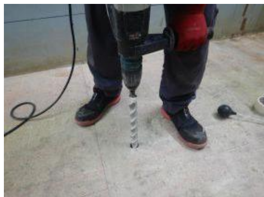
付写真-4. 2. 105 \phi 35\text{mm} ×385mm の穿孔状況
