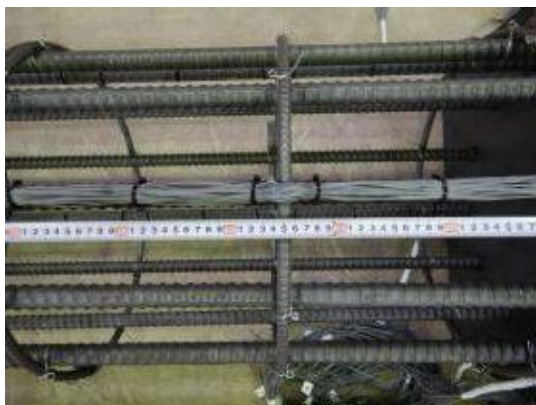
付写真-3. 1. 19. 2 配筋検査 (case2) 一部抜粋
