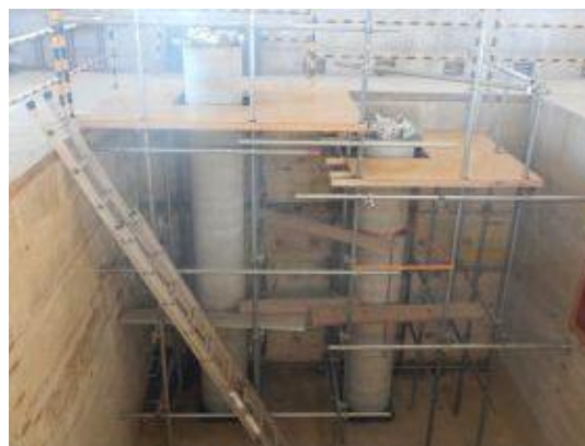
付写真-3.1.49 脱型完了
