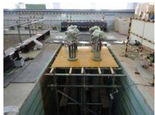
付写真-4. 2. 138 底型枠の設置
