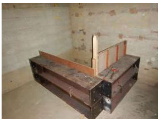
付写真-4. 2. 164 試験施工の仮土層
