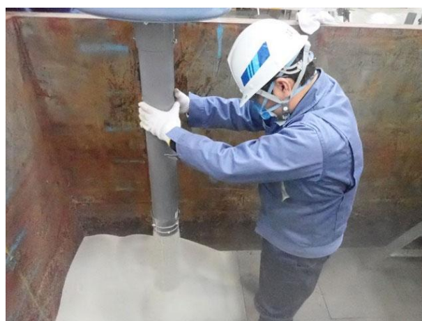
写真-3.3.3.2 空中落下法による人工地盤の製作状況
