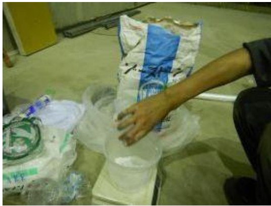
付写真-4. 2. 124 高強度石膏の計量
