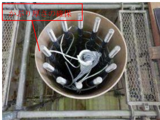
付写真-2. 2. 40 ボイド管の設置、かぶり厚確保
