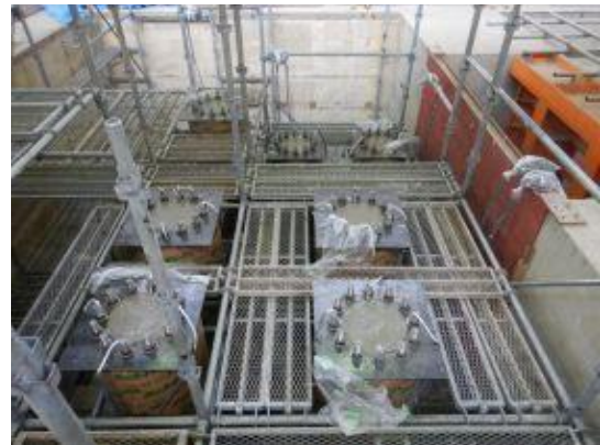
付写真-2.2.56 打設完了-02
