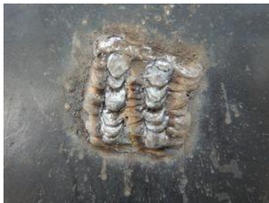
付写真-2.2.12 主鉄筋と①ベースプレートのシール溶接
