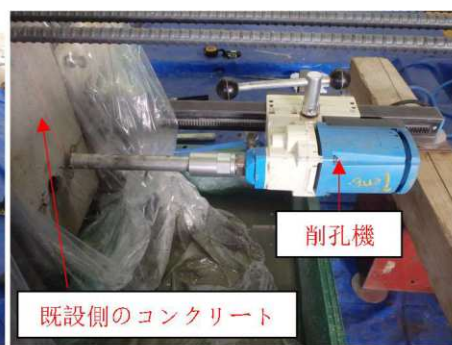
(b) 既設側の脱型後の削孔
