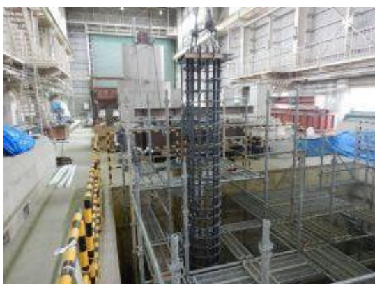
付写真-2.2.34 設置した作業足場と建て込み
