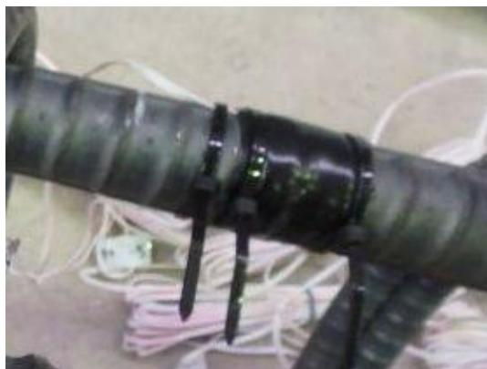
付写真-4. 2. 42 VM テープによる二次コーティング，ロックタイにて防水結束
