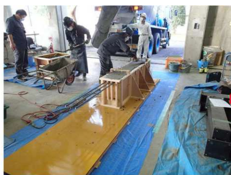
(a) 既設側のコンクリート打設
