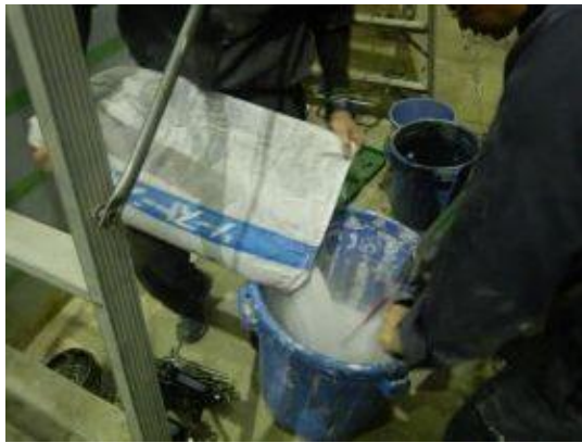
付写真-4. 2. 111 高強度石膏の攪拌
