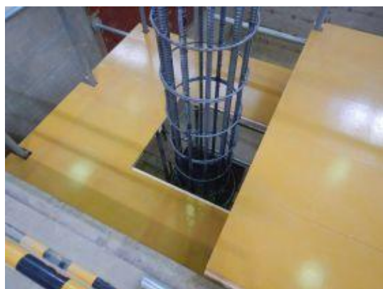
付写真-3.1.22 設置した作業足場と建て込み
