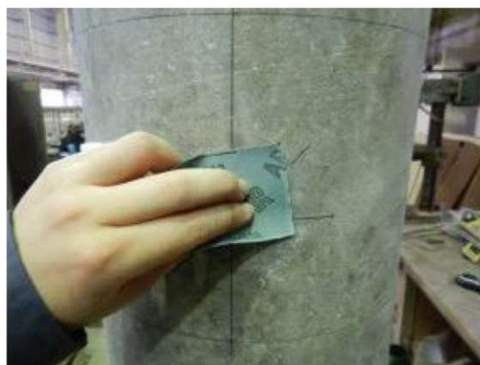
付写真-4.2.88 設置位置の表面の前処理
