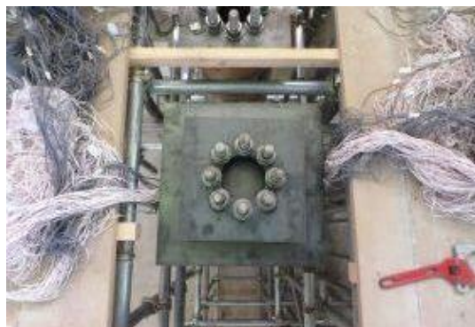
付写真-4.2.62 鉄筋かごの建込み
