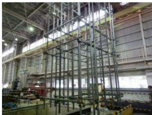
付写真-4. 2. 137 支保工足場の組み込み
