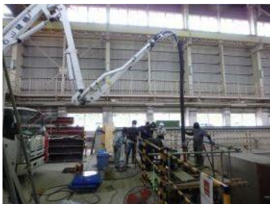
付写真-4. 2. 75 打設状況-03
