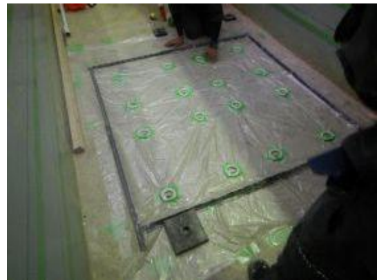
付写真-4. 2. 110 実験土層底面の養生
