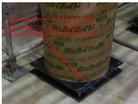
付写真-2. 2. 38 ボイド管を BP の溝へ固定
