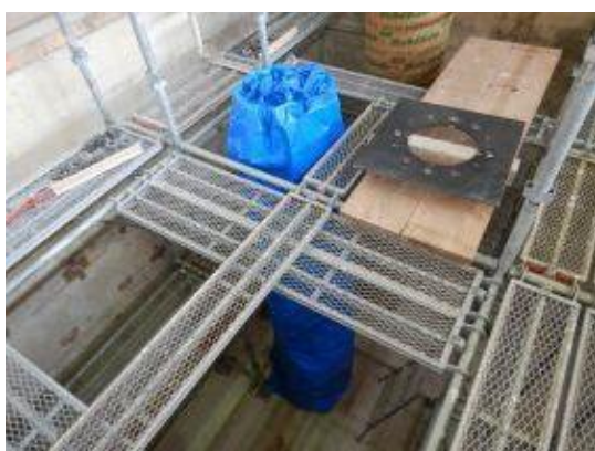
付写真-2.2.36 ブルーシートを用いて養生
