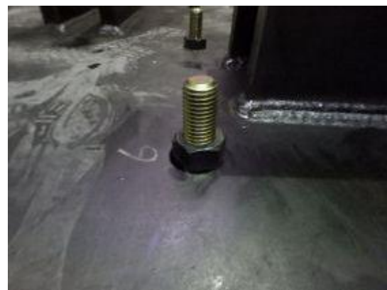
付写真-4. 2. 117 アンカーボルトの設置
