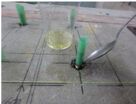
付写真-4. 2. 118 \phi 23 穿孔エポキシ樹脂の注入
