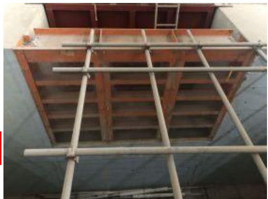
付写真-4.2.97 実験土層の外観-04
