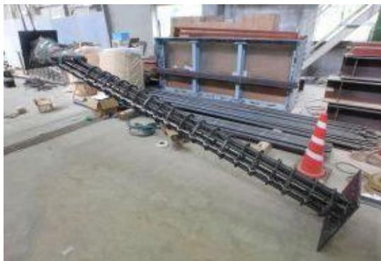
付写真-4.2.61 鉄筋かごの建て起こし
