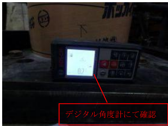
付写真-4. 2. 65 型枠底板四隅に設置した押しボルトにて型枠の立ち調整
