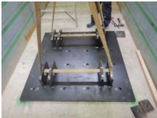
付写真-4. 2. 109 BP の仮置き、穿孔位置の確認
