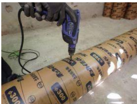
付写真-4.2.59 ボイド管への孔明け
