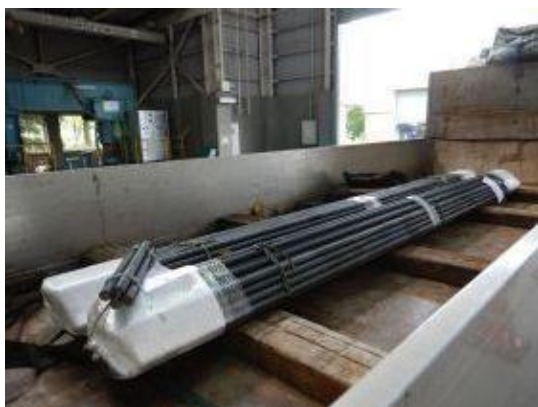
付写真-4.2.1 主鉄筋 SD345D32 の荷受け
