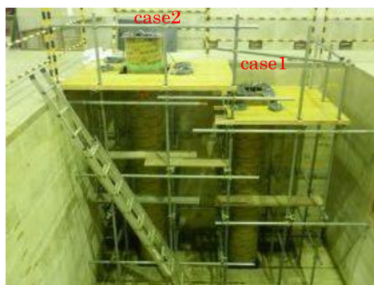
付写真-3.1.34 供試体 2 体分の型枠設置完了
