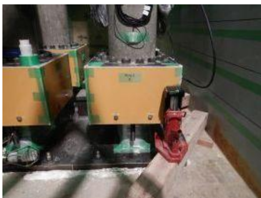
付写真-4. 2. 177 パネコートの設置
