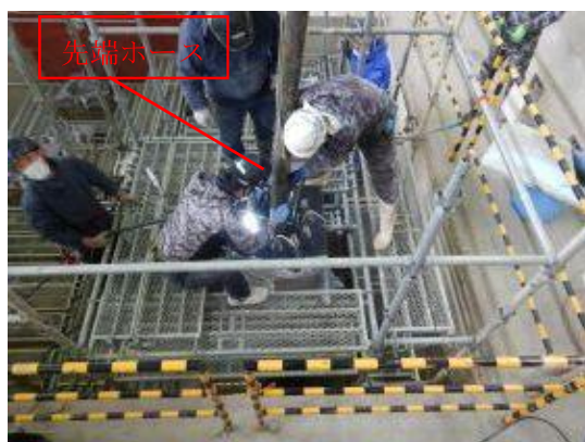
付写真-2.2.51 打設状況-01
