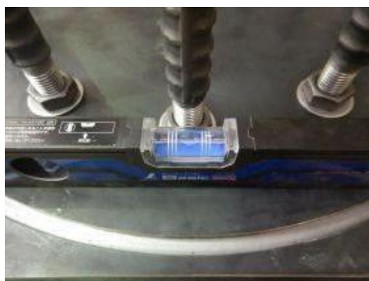
付写真-3.1.24 鉄筋かごの建ち確認
