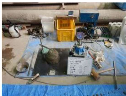
付写真-4.2.149 コンクリート受入検査
