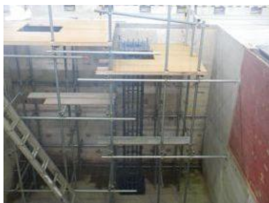
付写真-3.1.23 鉄筋かごの建て込み
