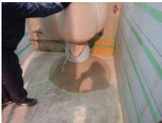
付写真-4. 2. 180 鹿島砂の投入
