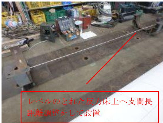
付写真-3.2.2 支点部治具下側の設置
