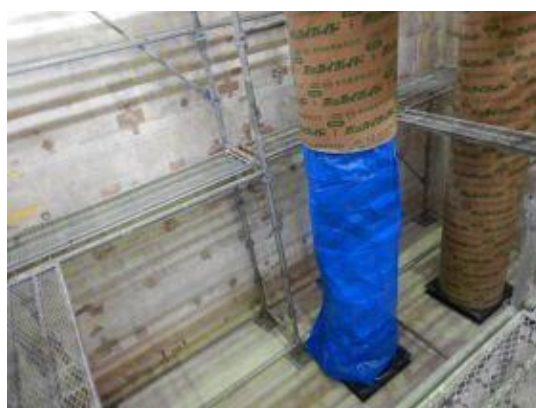
付写真-2.2.37 型枠材のボイド管の挿入
