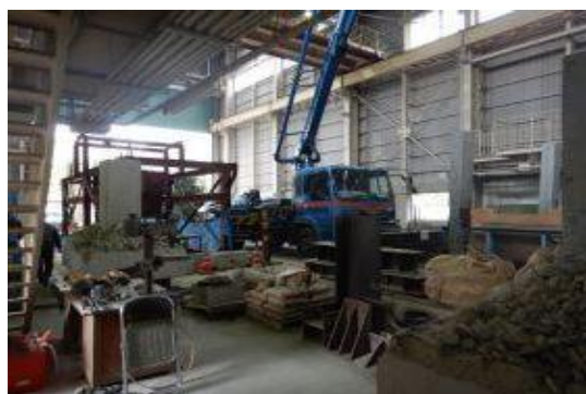
付写真-2.2.49 コンクリートポンプ車-01
