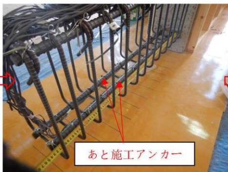
(d) 増設側の鉄筋が組立後の様子
