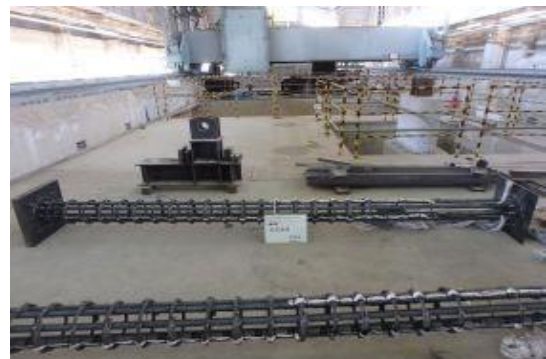
付写真-4.2.48 配筋検査 鉄筋かご 4体目
