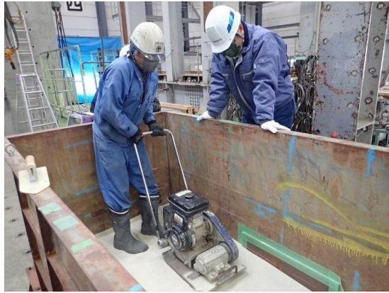
写真-3.3.3.3 転圧による人工地盤の製作状況
