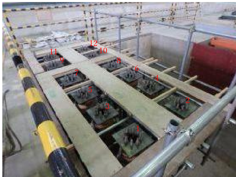
付写真-4. 2. 66 杭供試体 12 体分の型枠設置完了
