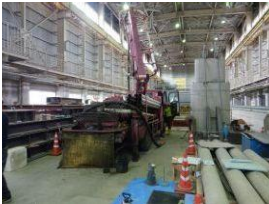
付写真-3.1.40 コンクリートポンプ車-01
