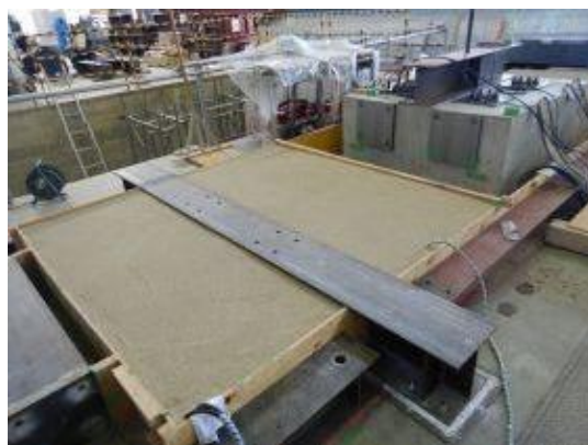
付写真-4. 2. 188 上載荷重用の型枠
