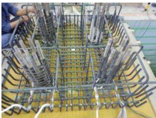
付写真-4. 2. 143 定着部帯鉄筋の配筋
