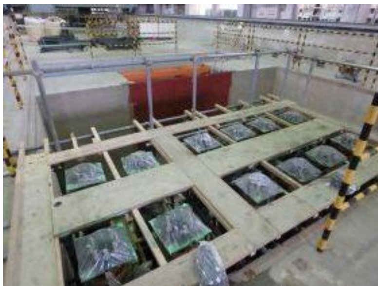
付写真-4. 2. 78 打設完了後の養生
