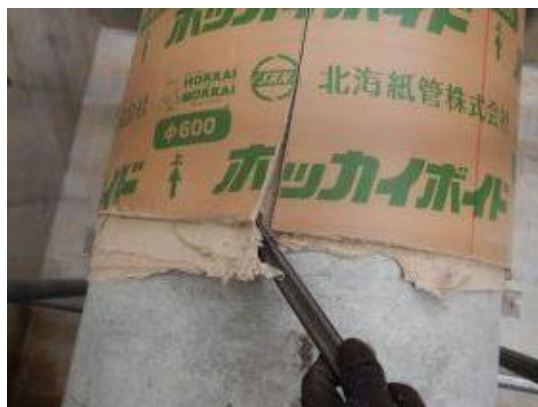
付写真-3.1.48 脱型状況
