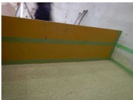
付写真-4. 2. 166 1層目 所定高さ 250mm
