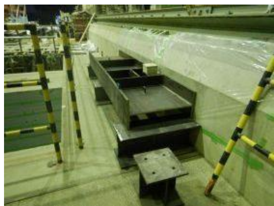
付写真-4. 2. 121 反力梁の仮置き
