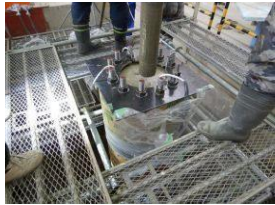
付写真-2.2.54 打設状況-04
