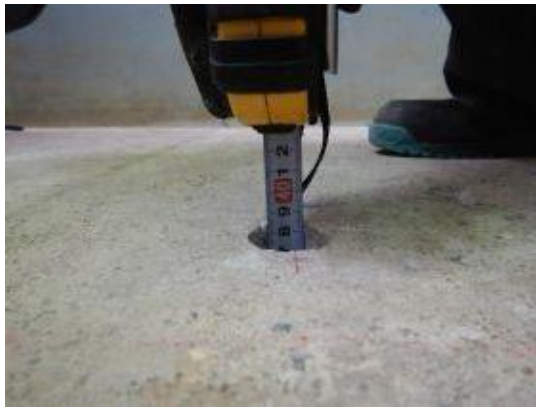
付写真-4. 2. 106 穿孔深さの確認
