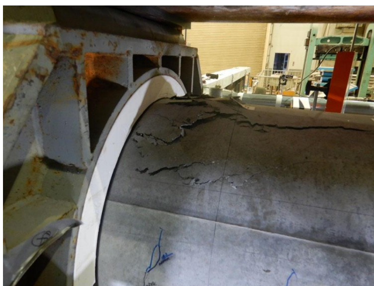
(b) コンクリート圧壊箇所
