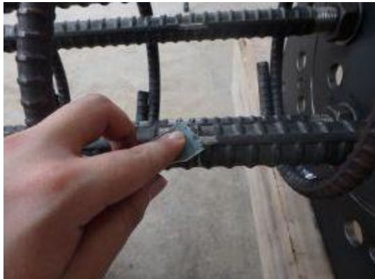
付写真-4. 2. 37 貼付け範囲の黒皮除去
