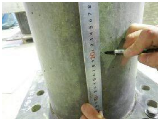
付写真-4. 2. 84 杭先端から 200mm ピッチ罫書き
