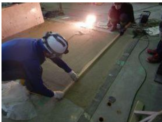
付写真-4. 2. 183 土層天端のすり切り整形
