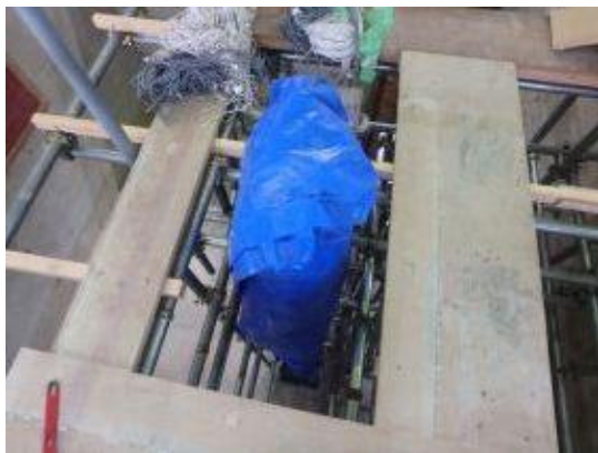
付写真-4. 2. 63 ブルーシートを用いて養生
