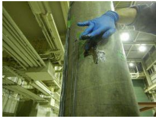
付写真-4.2.92 PSにて表面コーティング
