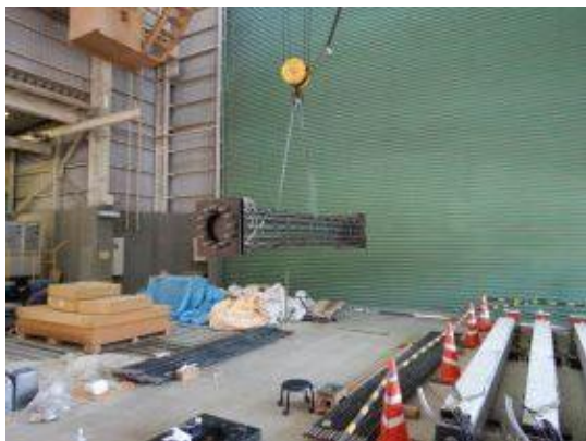
付写真-2.2.32 鉄筋かごの荷吊り
