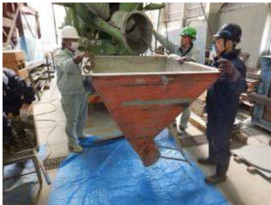
付写真-4. 2. 154 準備したコンクリートバケット
