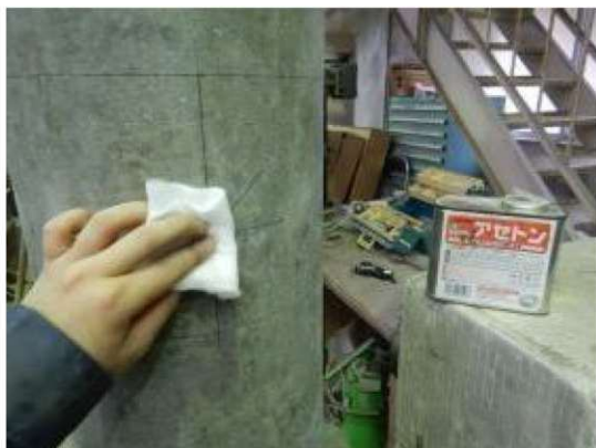
付写真-4.2.89 アセトンにて脱脂、清掃
