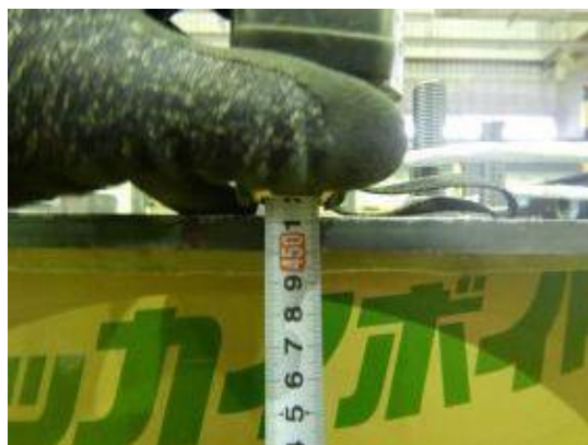
付写真-3.1.29 case2 用型枠延長の確認
