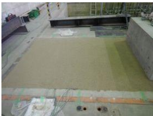
付写真-4. 2. 186 鹿島砂投入完了-03
