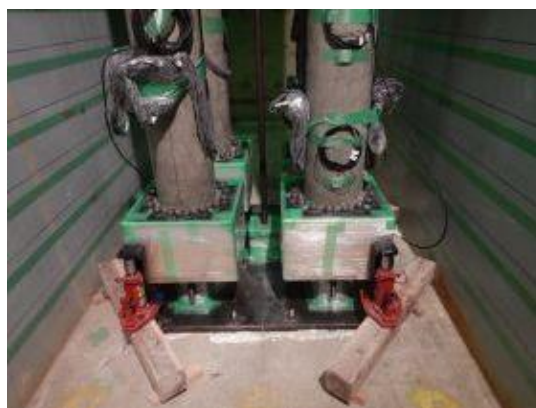
付写真-4. 2. 178 ロードセル部の養生
