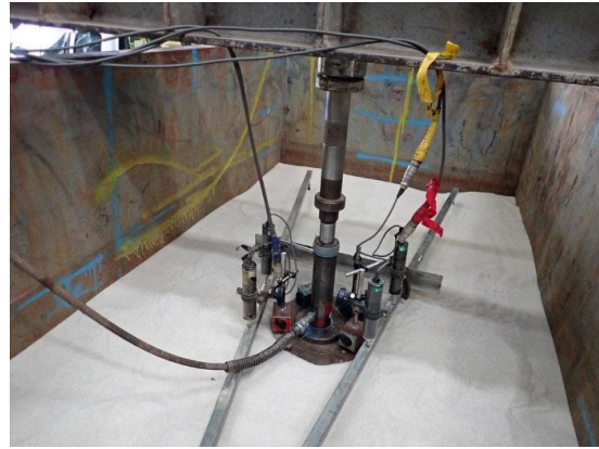
写真-3.3.3.4 平板载荷試験状況
