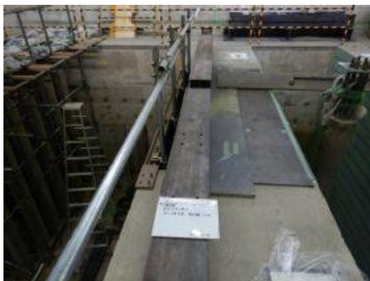
付写真-4. 2. 34 浮上り防止装置受入検査
