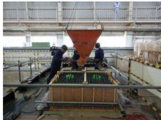
付写真-4. 2. 155 天井クレーンでの運搬
