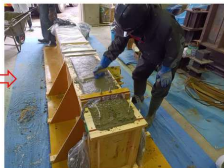
(e) 増設側のコンクリート打設
