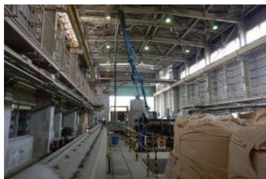
付写真-2.2.50 コンクリートポンプ車-02
